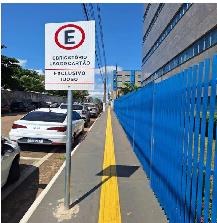
Figura 1 - Piso tátil instalado na parte externa da sede do TRT14, em conformidade com as normas de acessibilidade, destinado à orientação de pessoas com deficiência visual (Porto Velho/RO, 2025). Fonte: Auditoria Interna – SEAUDI, 2025.
