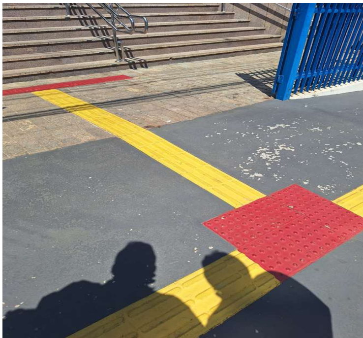
Figura 2 – Piso tátil direcional e de alerta antecedendo a escadaria de acesso à sede do TRT14, e corrimão em aço inox, promovendo segurança e acessibilidade aos usuários com deficiência visual (Porto Velho/RO, 2025). Fonte: Auditoria Interna – SEAUDI, 2025.
