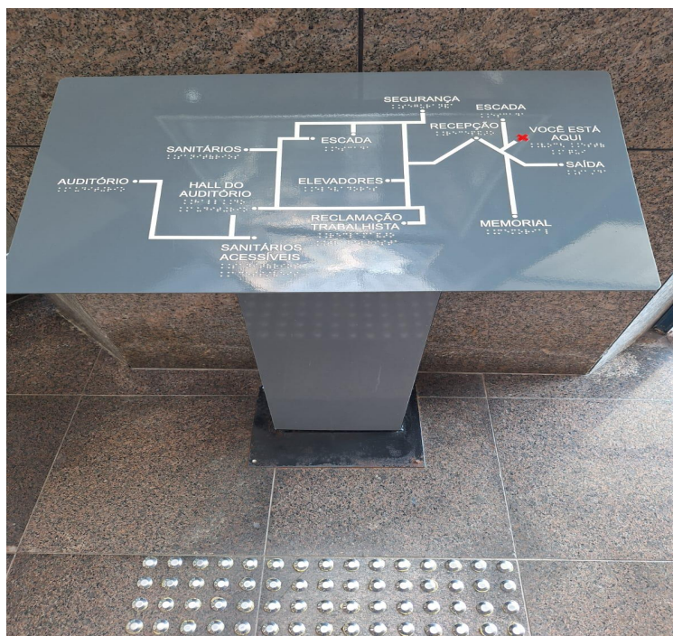
Figura 3 – Mapa tátil de localização instalado no hall de entrada da sede do TRT14, com informações em braile, indicando setores e fluxos de acesso interno (Porto Velho/RO, 2025). Fonte: Auditoria Interna – SEAUDI, 2025.
