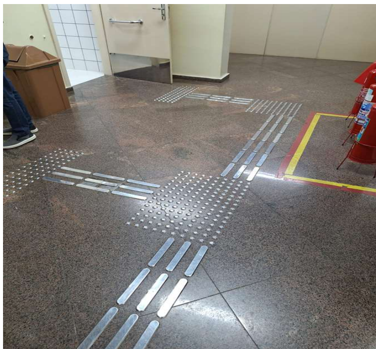
Figura 4 – Piso tátil interno direcionando o acesso aos sanitários da sede do TRT14, com demarcações em aço inoxidável em conformidade com a NBR 9050/2020 (Porto Velho/RO, 2025). Fonte: Auditoria Interna – SEAUDI, 2025.
