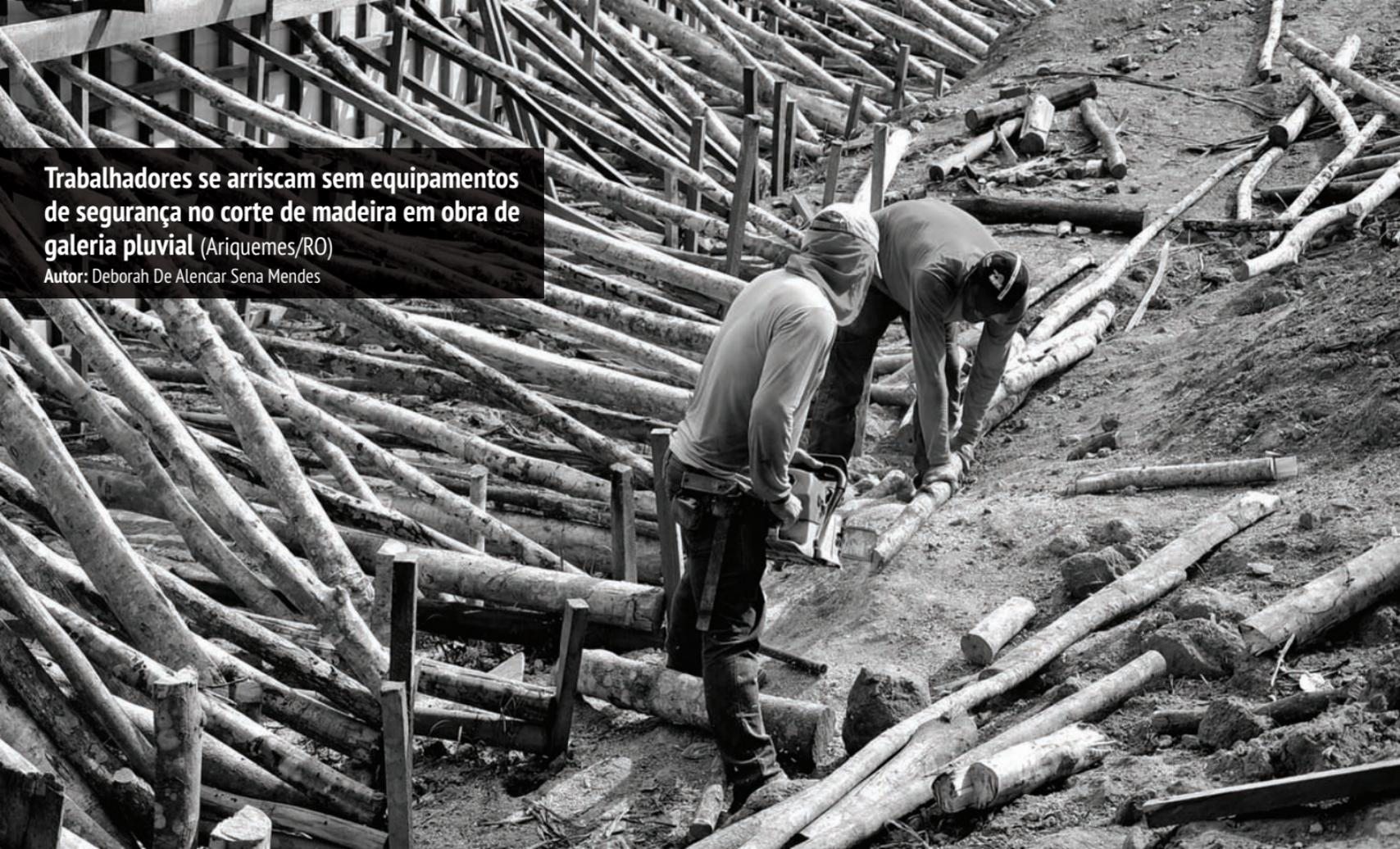
**Trabalhadores se arriscam sem equipamentos de segurança no corte de madeira em obra de galeria pluvial (Ariquemes/RO)**
