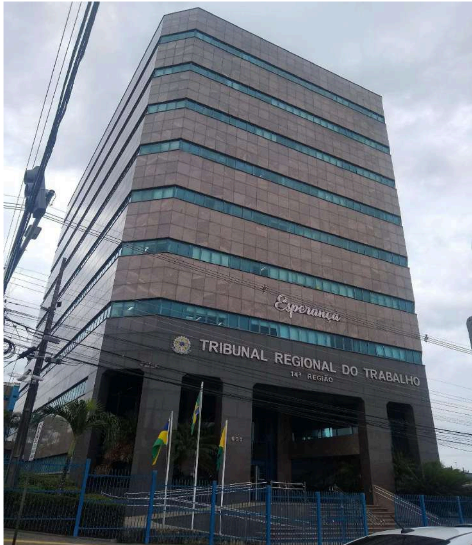
Edifício-Sede do TRT da 14ª Região
