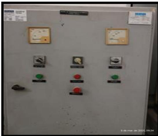
Figura 13: QUADRO DE TRANSFERÊNCIA AUTOMÁTICA - QTA
