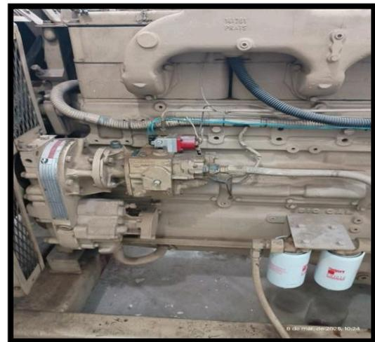
Figura 20: VISTA LATERAL - FIOS SOLTOS SEM PROTEÇÃO
