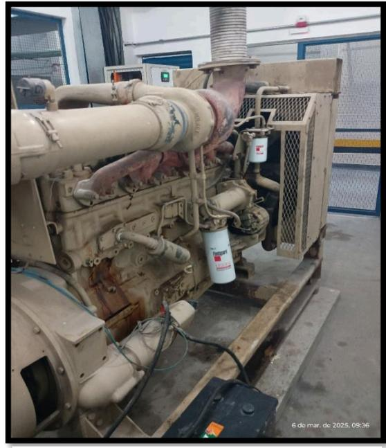
Figura 18:VISTA LATERAL - FIOS SEM PROTEÇÃO E VAZAMENTOS
