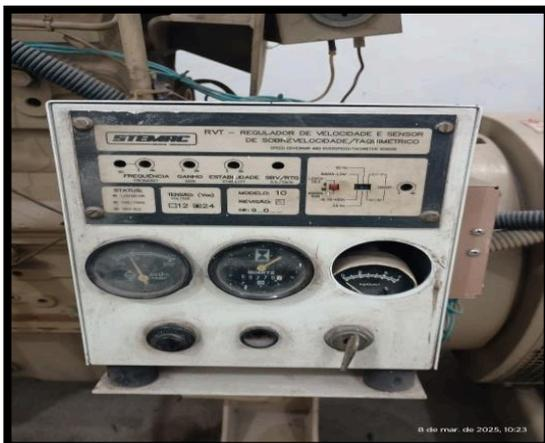
Figura 21: CONTROLADOR DE VELOCIDADE ANALÓGICO
