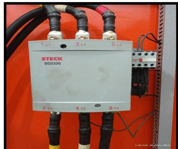
Figura 14: CONTADORA DE BY-PASS (IMPLEMENTAÇÃO DE RELÉ/ CONTADORA REDUNDANTE).
