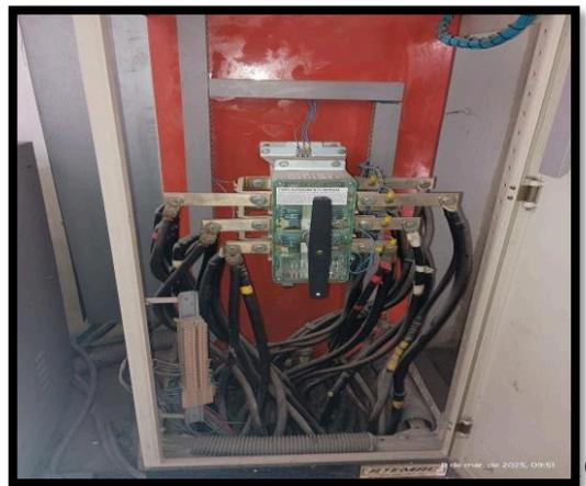
Figura 22: QUADRO DE TRANSFERÊNCIA AUTOMÁTICO - QTA PRÉDIO
