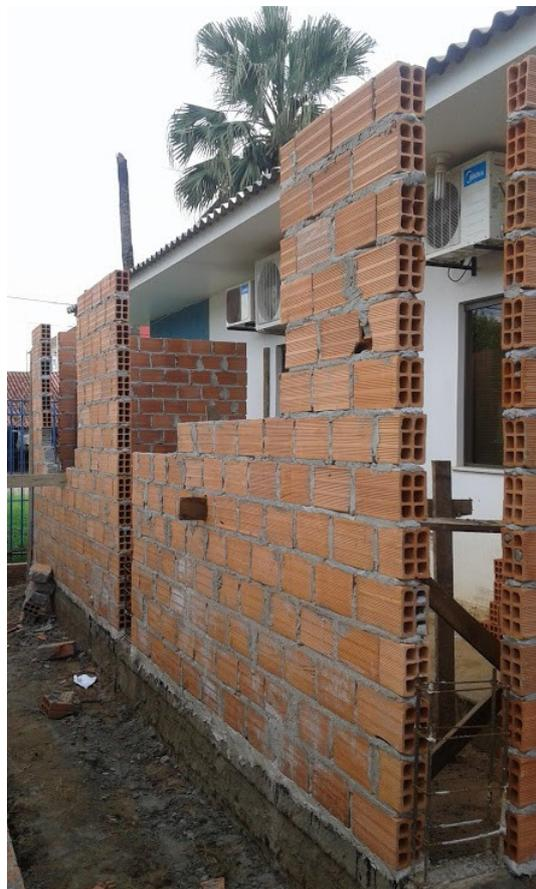
*Ilustração 8: Elevação de alvenaria para ampliação das salas existentes.*
