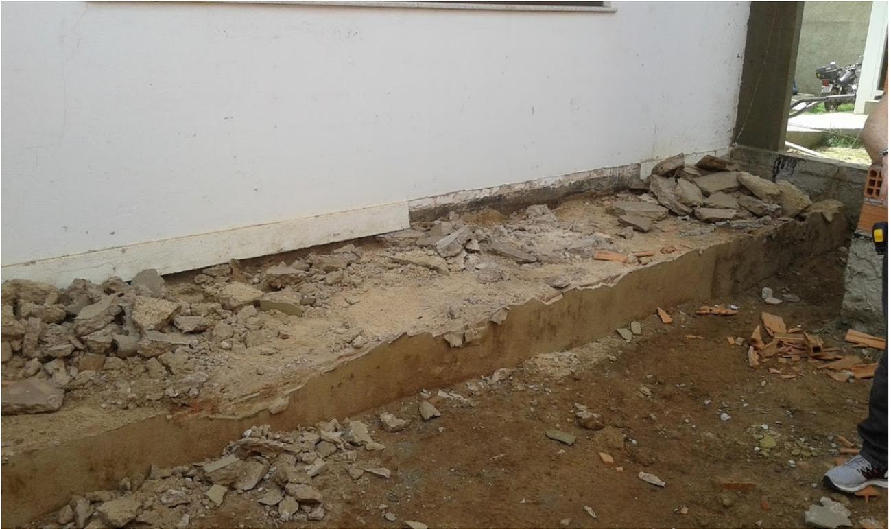
*Ilustração 5: Demolição de calçadas ao redor do prédio.*
