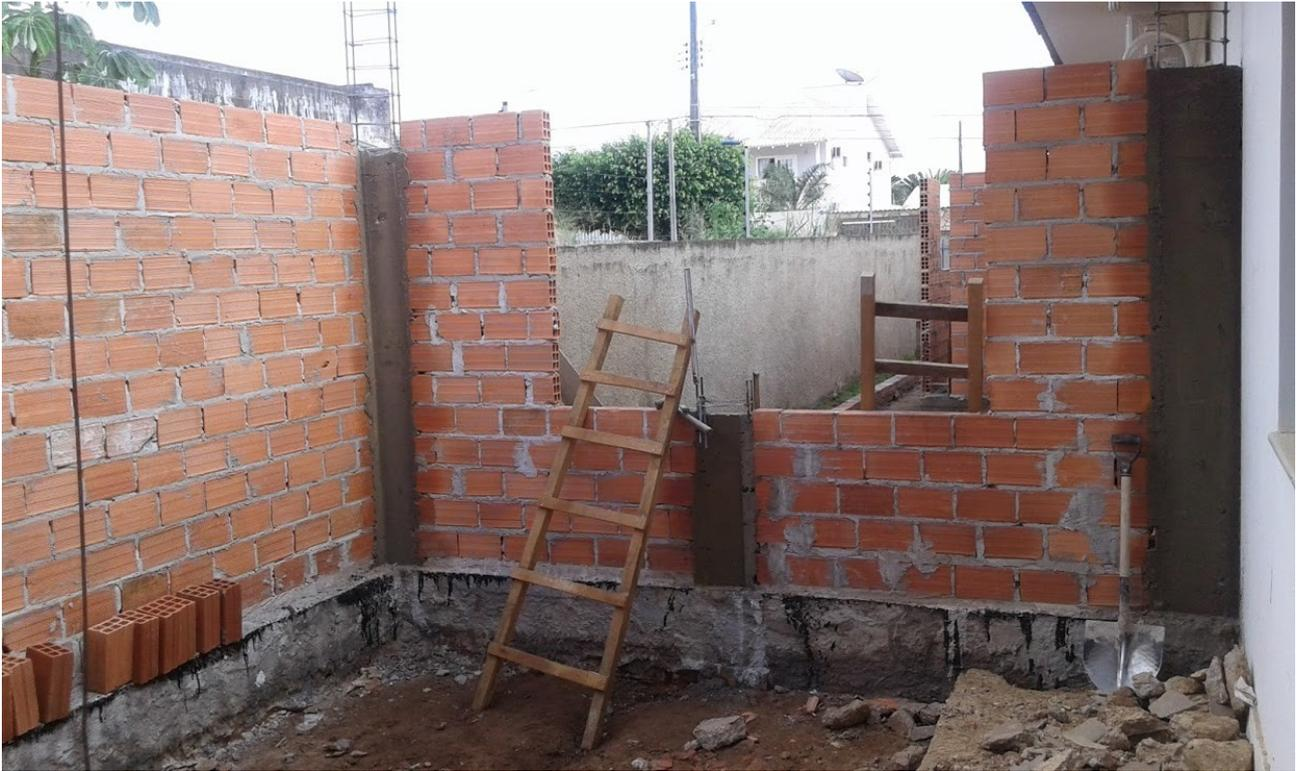
*Ilustração 11: Execução de alvenaria com vãos para janelas.*
