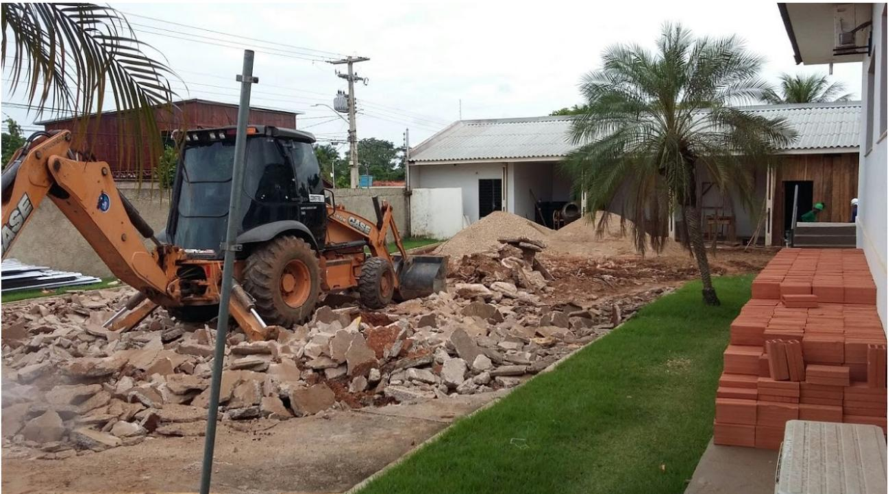
*Ilustração 1: Serviços de demolições e retiradas.*
