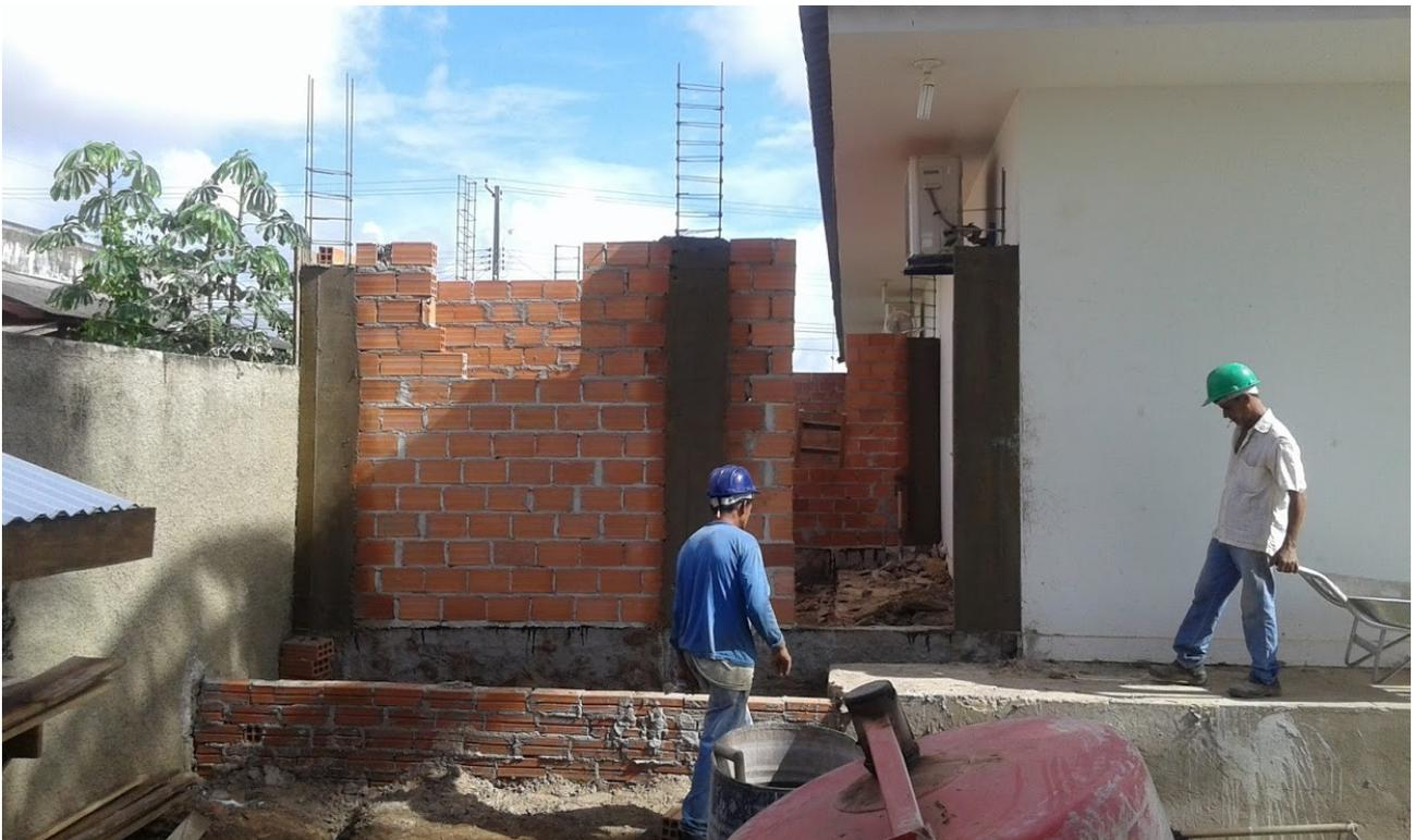
*Ilustração 10: Elevação de alvenaria e execução de pilares como elementos estruturais.*
