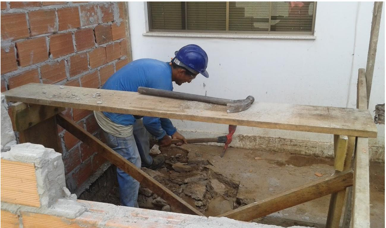
*Ilustração 6: Demolição manual de calçadas ao redor do prédio.*
