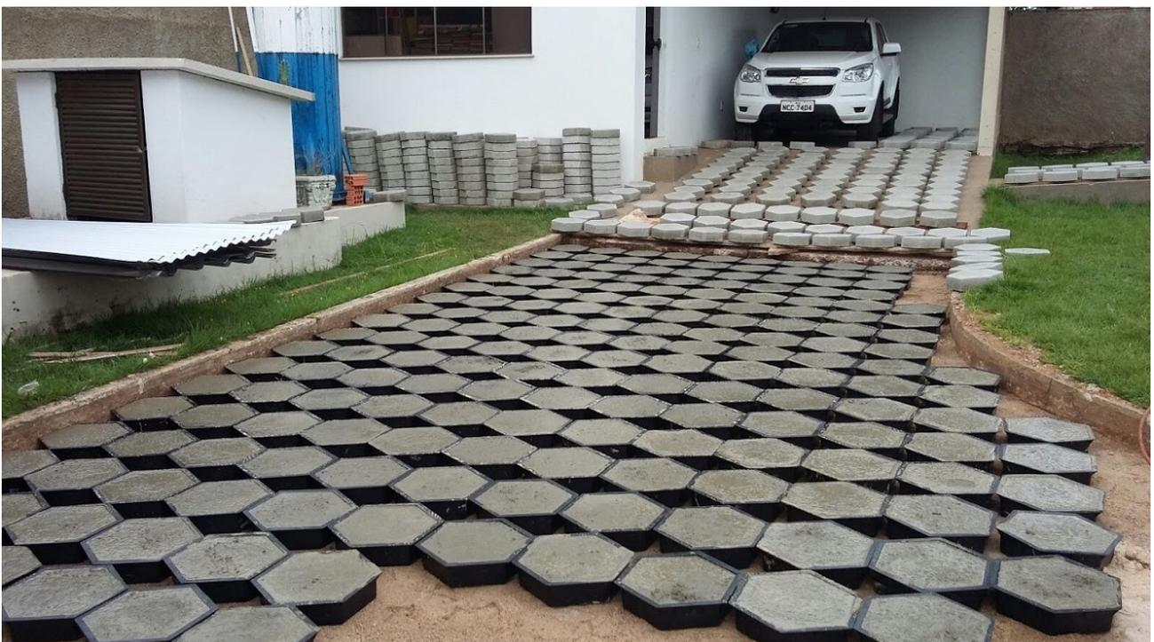
*Ilustração 2: Execução de calçada tipo bloket.*
