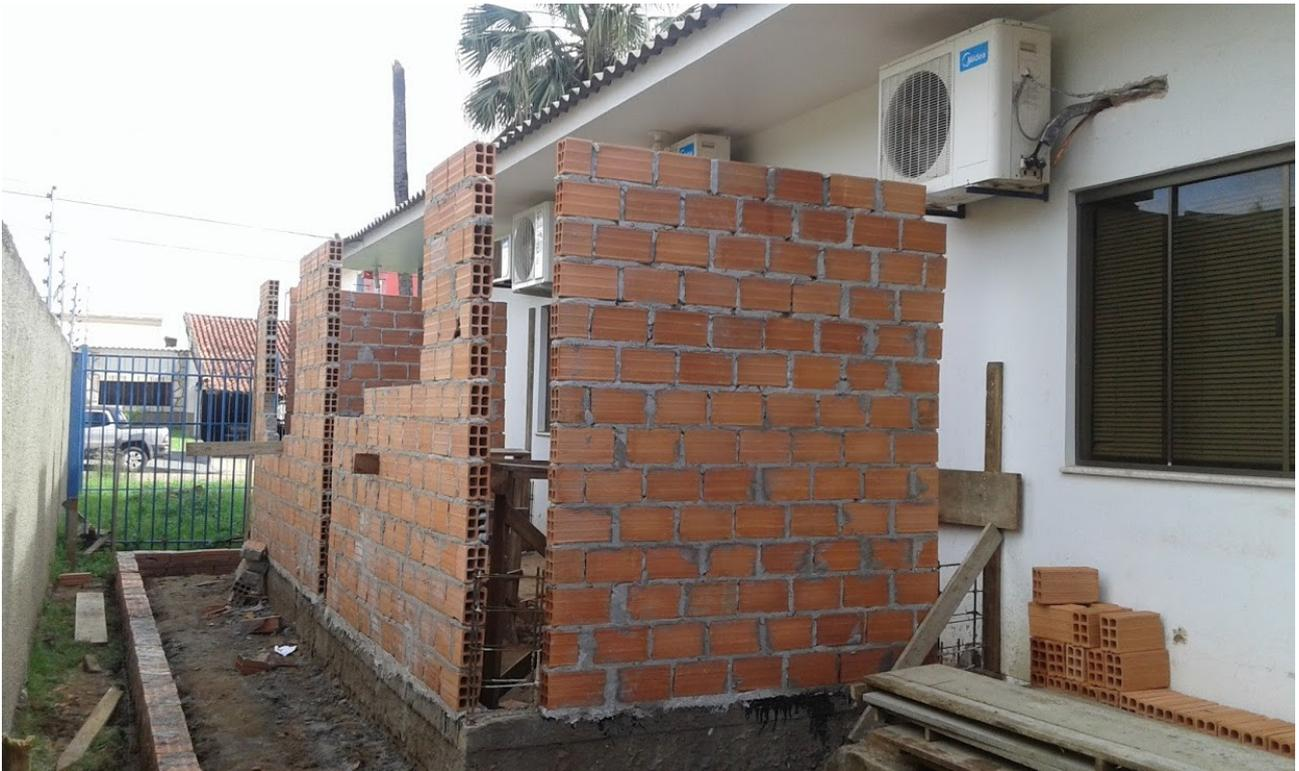
*Ilustração 9: Elevação de alvenaria para ampliação de salas existentes.*
