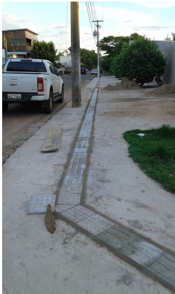
Ilustração 6: Calçada com piso direcional em execução.
