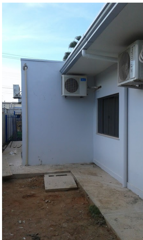
Ilustração 2: Local ampliado em fase de finalização.
