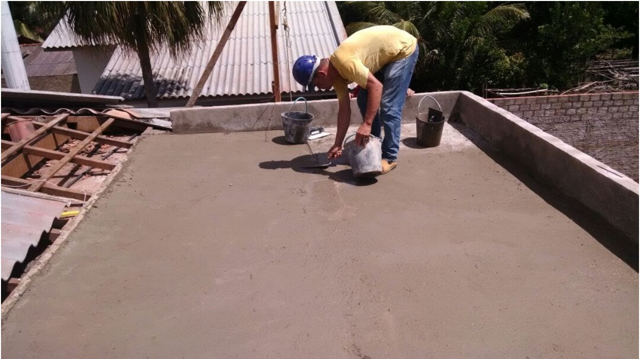
Ilustração 7: Execução de laje de cobertura da área ampliada.
