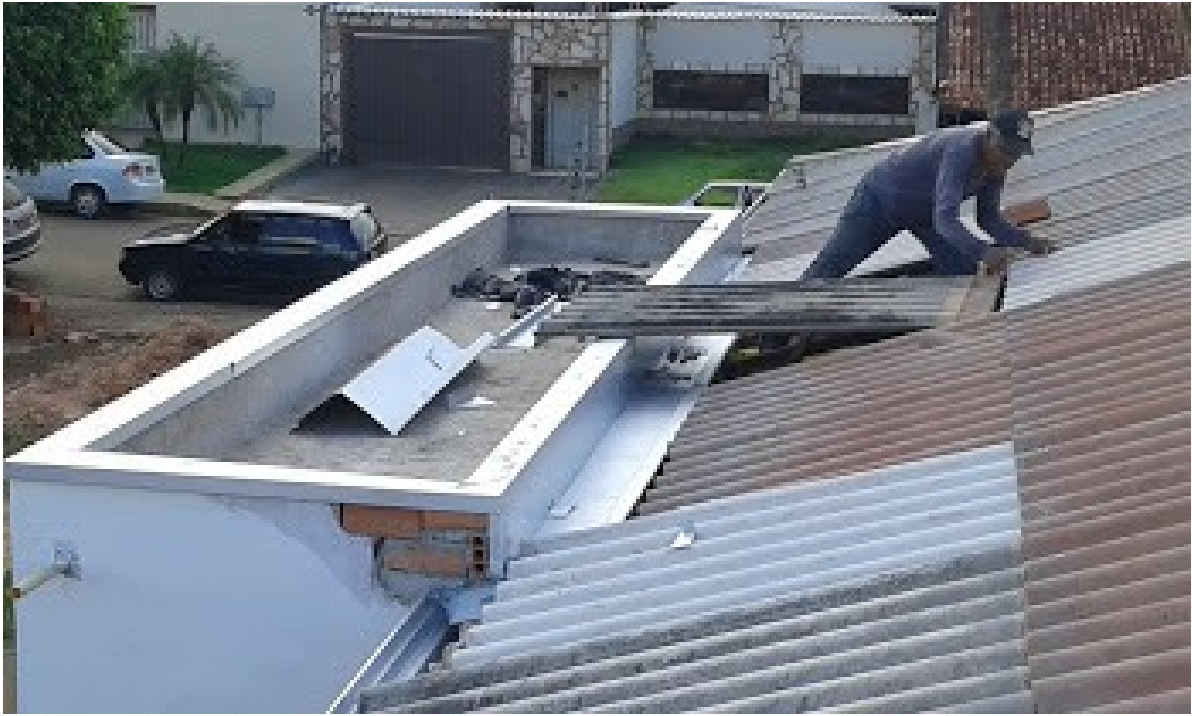
Ilustração 9: Visão da laje de cobertura da área ampliada.
