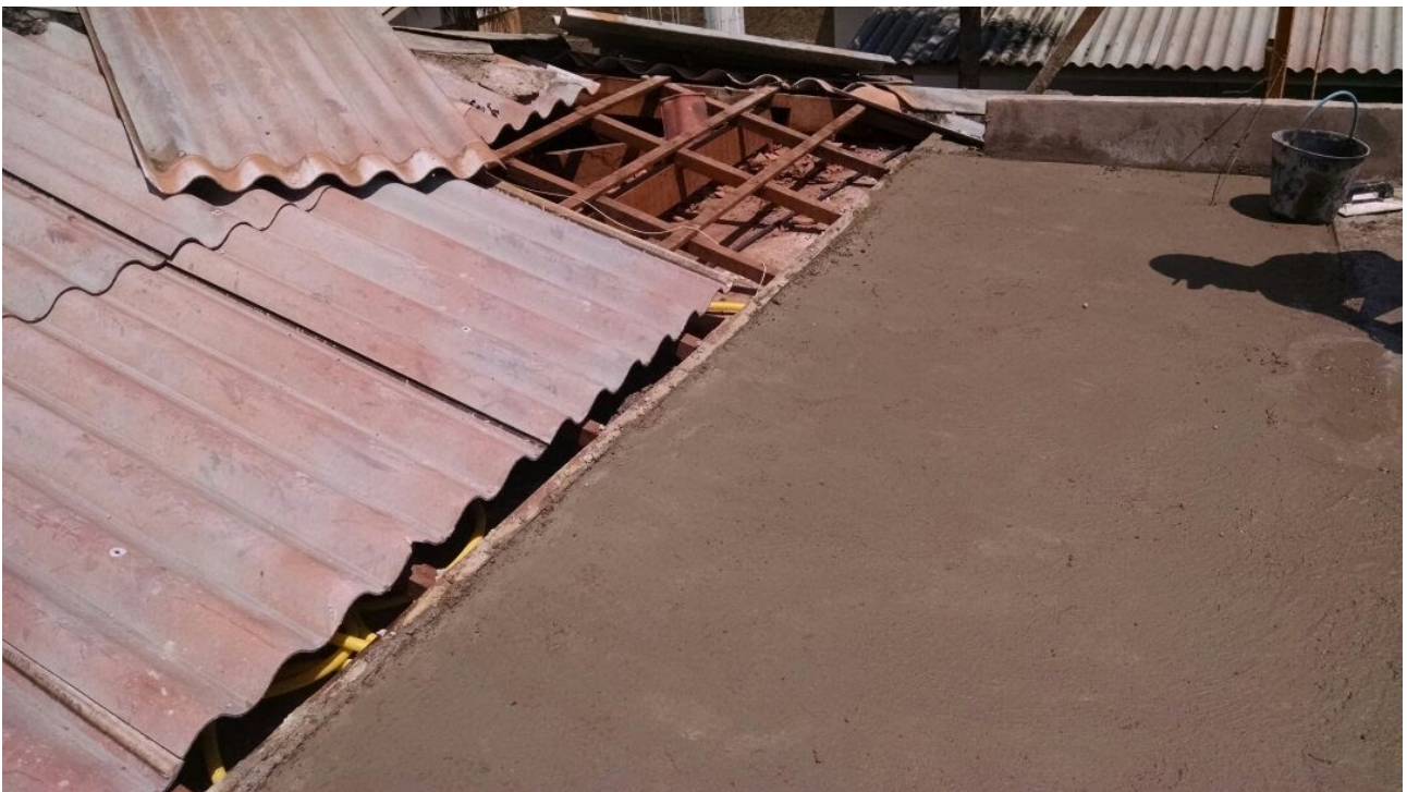
Ilustração 8: Execução de laje de cobertura de área ampliada
