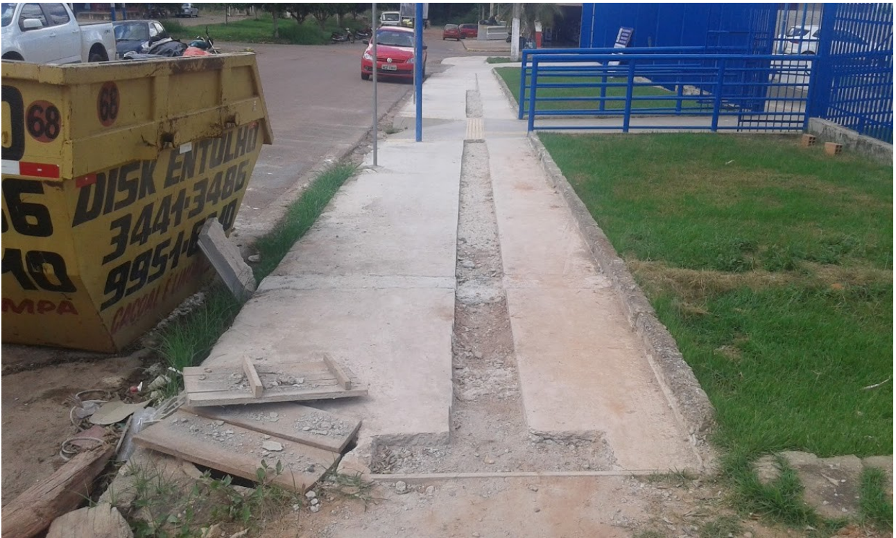
Ilustração 5: Execução de calçadas externas com piso tátil.
