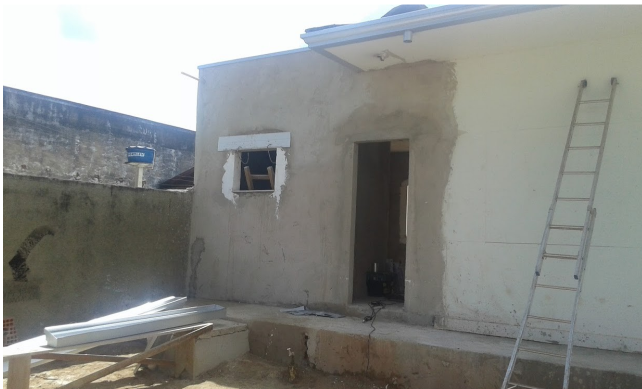
Ilustração 1: Execução de reboco na área ampliada.
