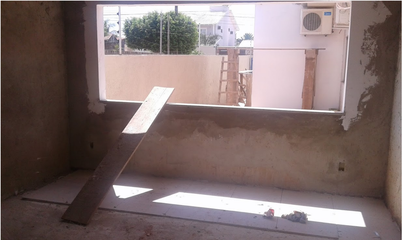
Ilustração 3: Arremate de vão e início da aplicação de revestimento cerâmico. Vista ao fundo de área ampliada.
