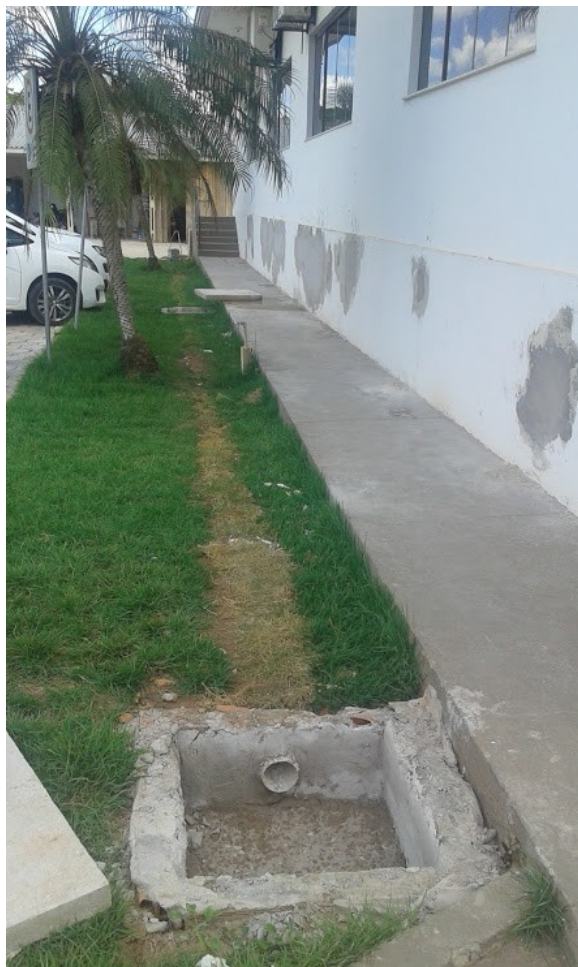
Ilustração 10: Visão de calçadas parcialmente executadas e caixa de drenagem pluvial.
