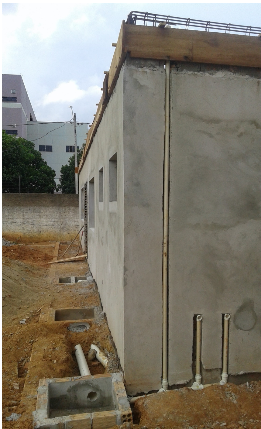
Ilustração 9: Visão da área ampliada, já rebocada e de elementos tipo caixa de passagem para drenagem pluvial e esgoto sanitário.
