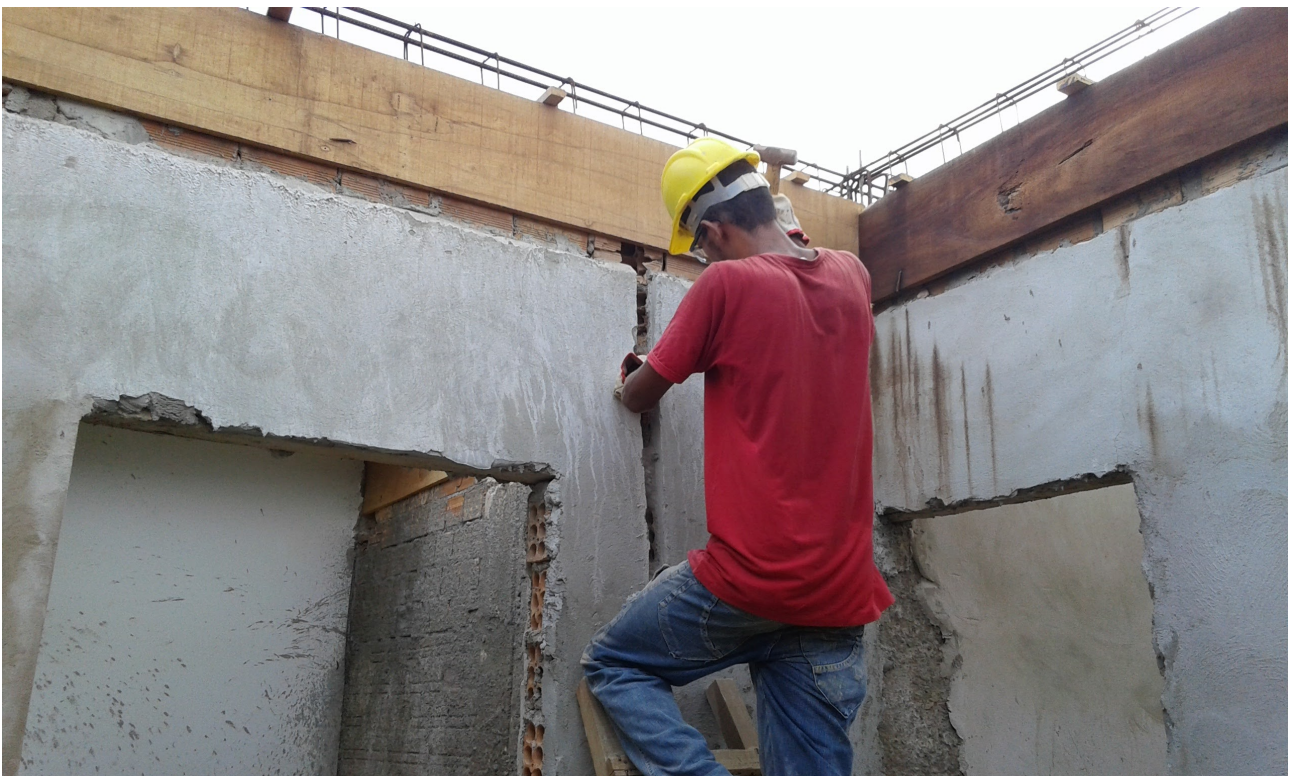
Ilustração 4: Abertura de rasgo em parede para implantação de eletroduto.
