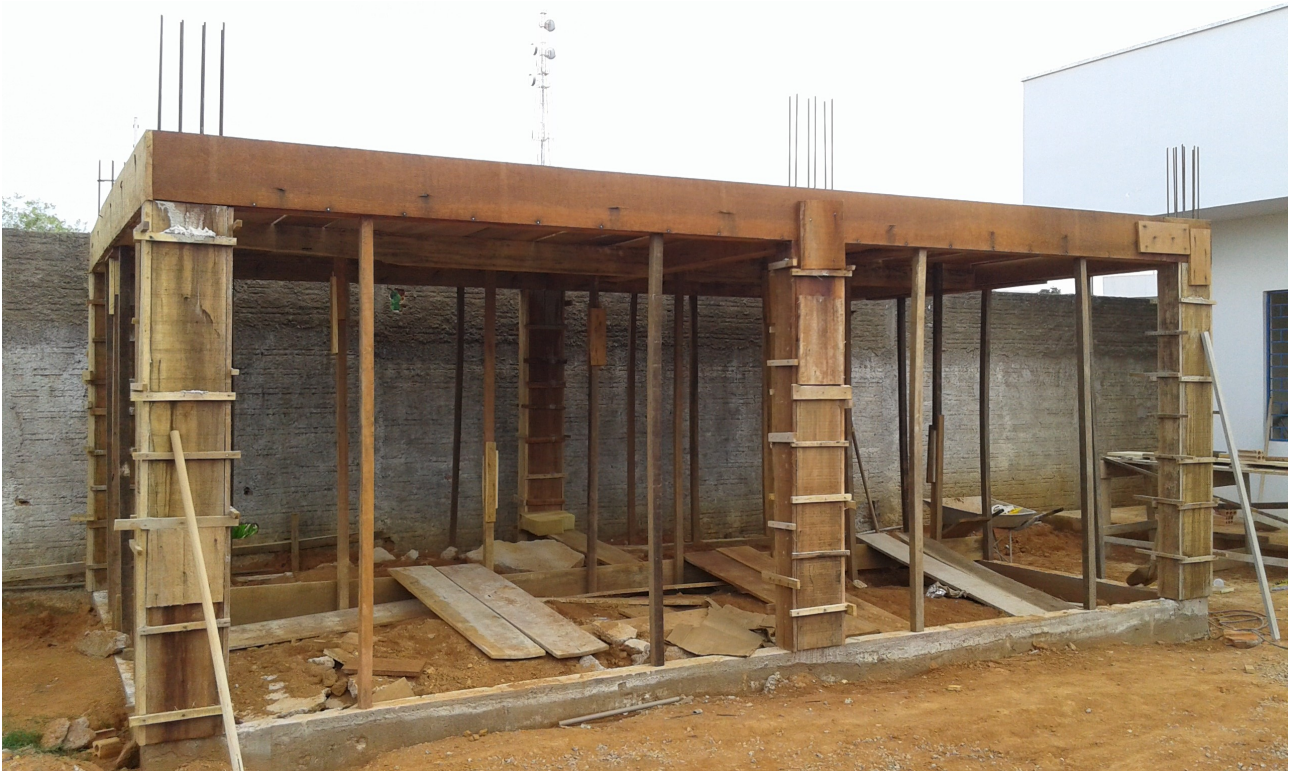
Ilustração 1: Cimbramento e concretagem de vigas e pilares – Reservatório Elevado.
