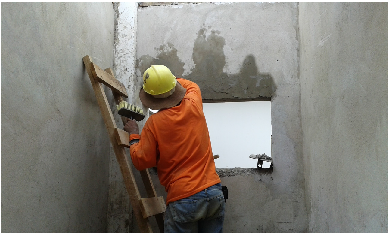
Ilustração 8: Arremate de abertura para janela basculante.
