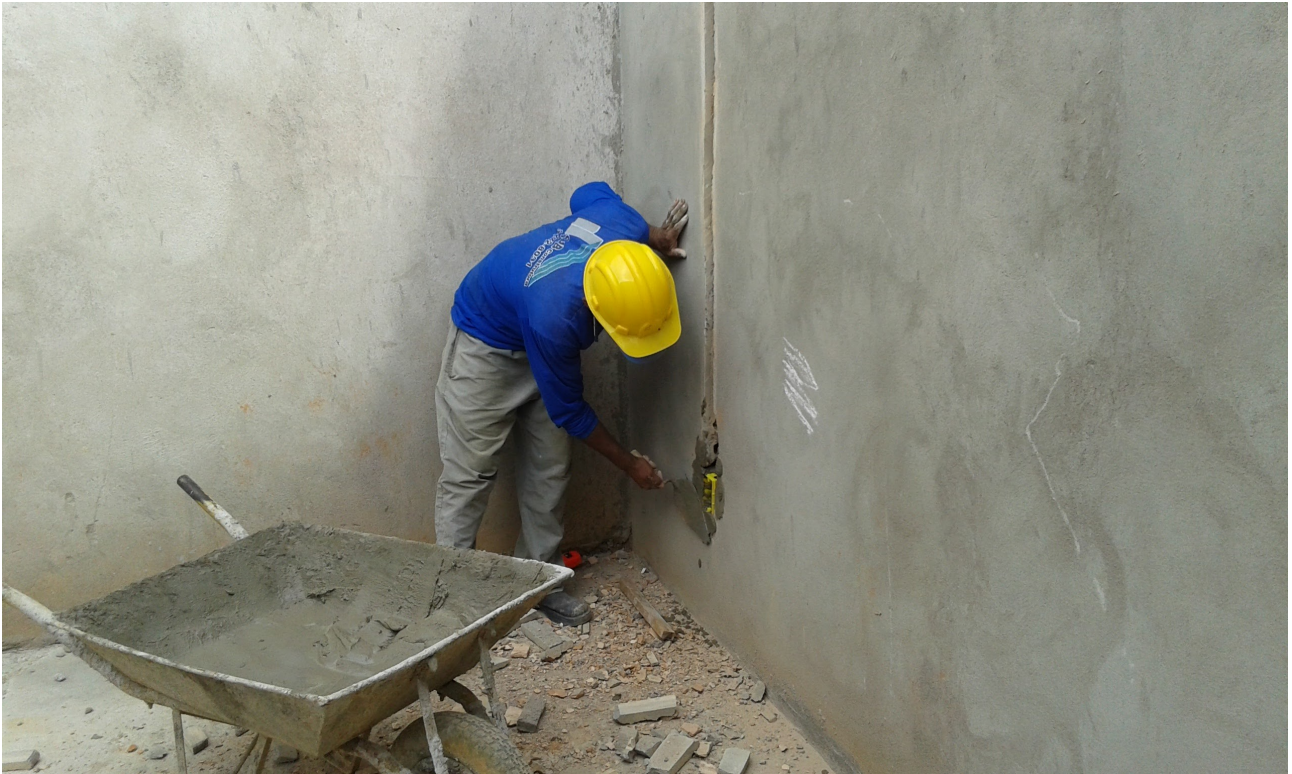
Ilustração 5: Acabamento de instalação de ponto elétrico.
