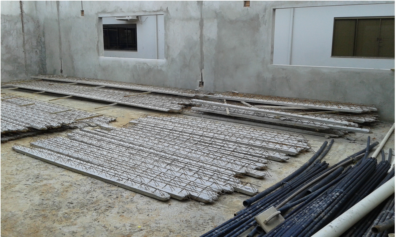
Ilustração 7: Vigotas treliçadas para execução de lajes de cobertura.
