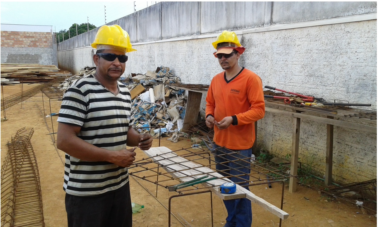
Ilustração 3: Área de corte e dobra das armaduras da obra.
