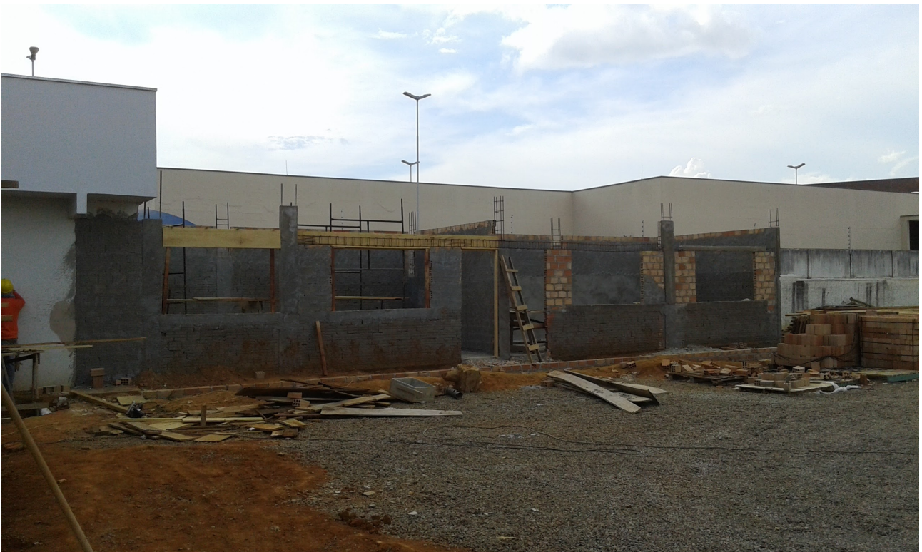
Ilustração 2: Ampliação do Fórum Trabalhista, visão geral de alvenarias, superestrutura, vergas e contra vergas. - Arquivos.
