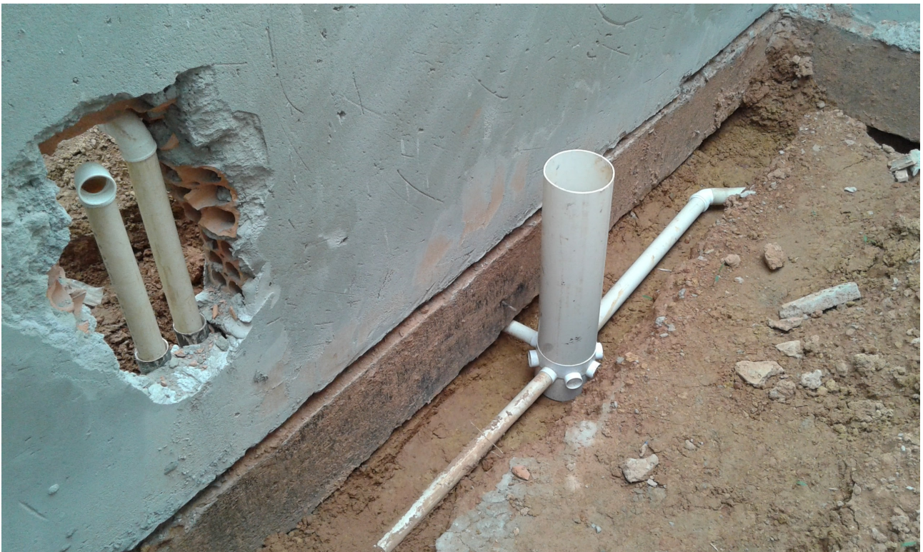
Ilustração 6: Execução de elementos hidrossanitários.
