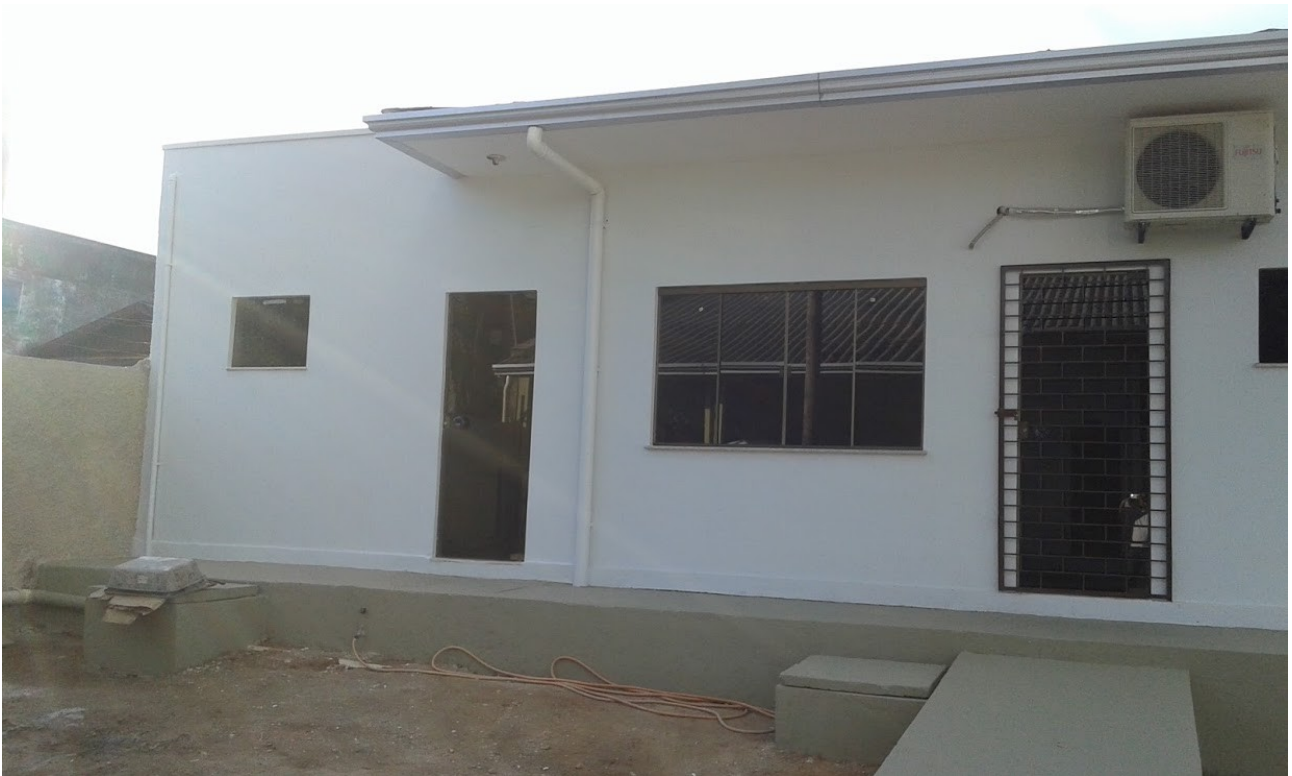
Ilustração 3: Área reformada em fase de conclusão
