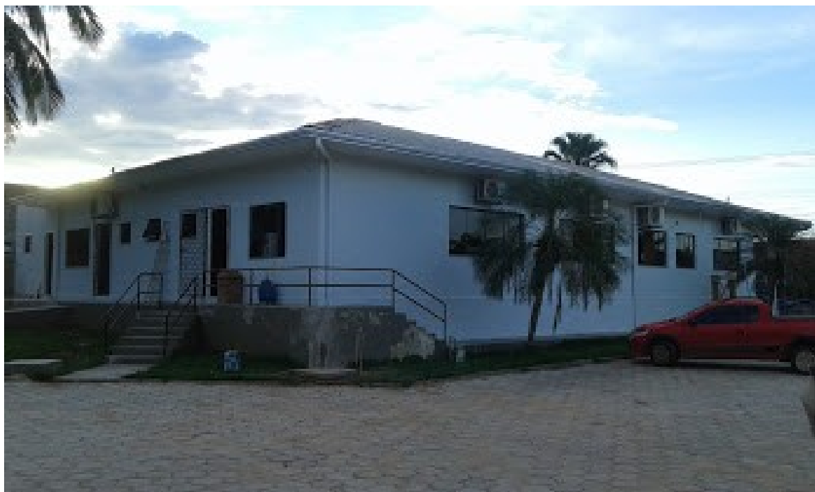
Ilustração 2: Visão externa da reforma em fase de conclusão.
