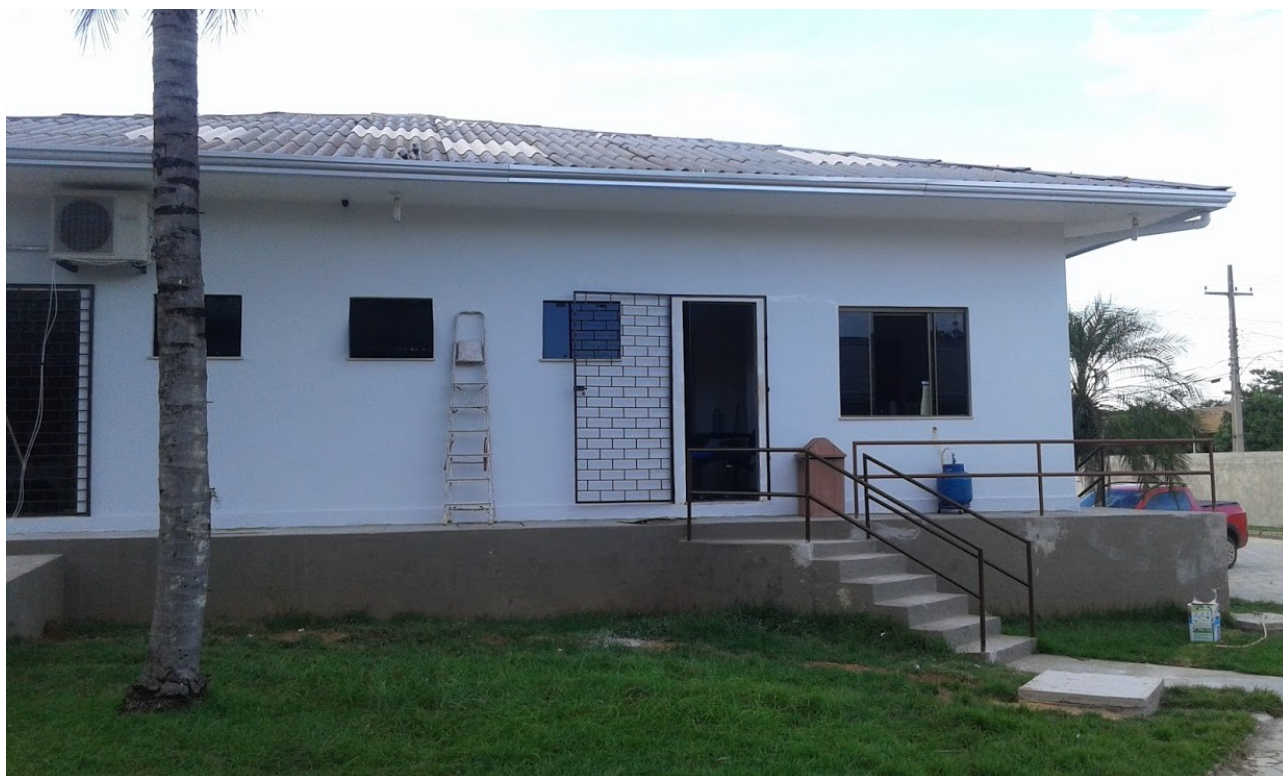
Ilustração 1: Visão externa da reforma em fase de conclusão.
