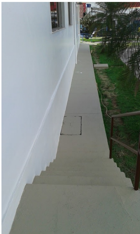
Ilustração 9: Calçada ao redor do prédio concluída.
