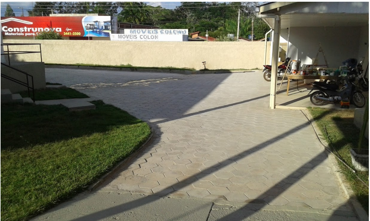
Ilustração 8: Visão externa da reforma em fase de conclusão.
