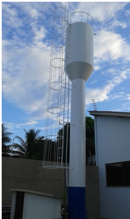
Ilustração 4: Reservatório elevado de água concluído.
