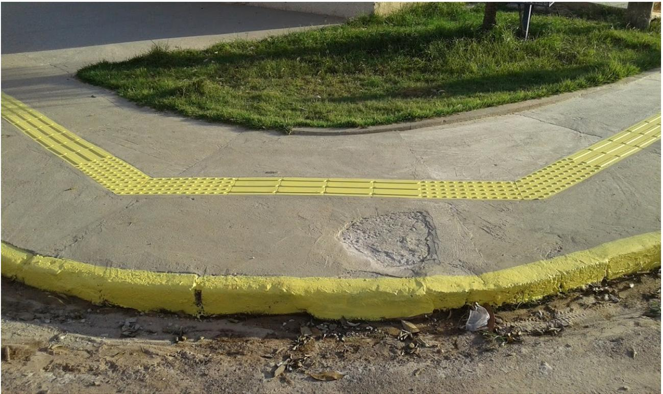
*Ilustração 3: Piso tátil aplicado e sinalização de áreas de estacionamento não permitido.*
