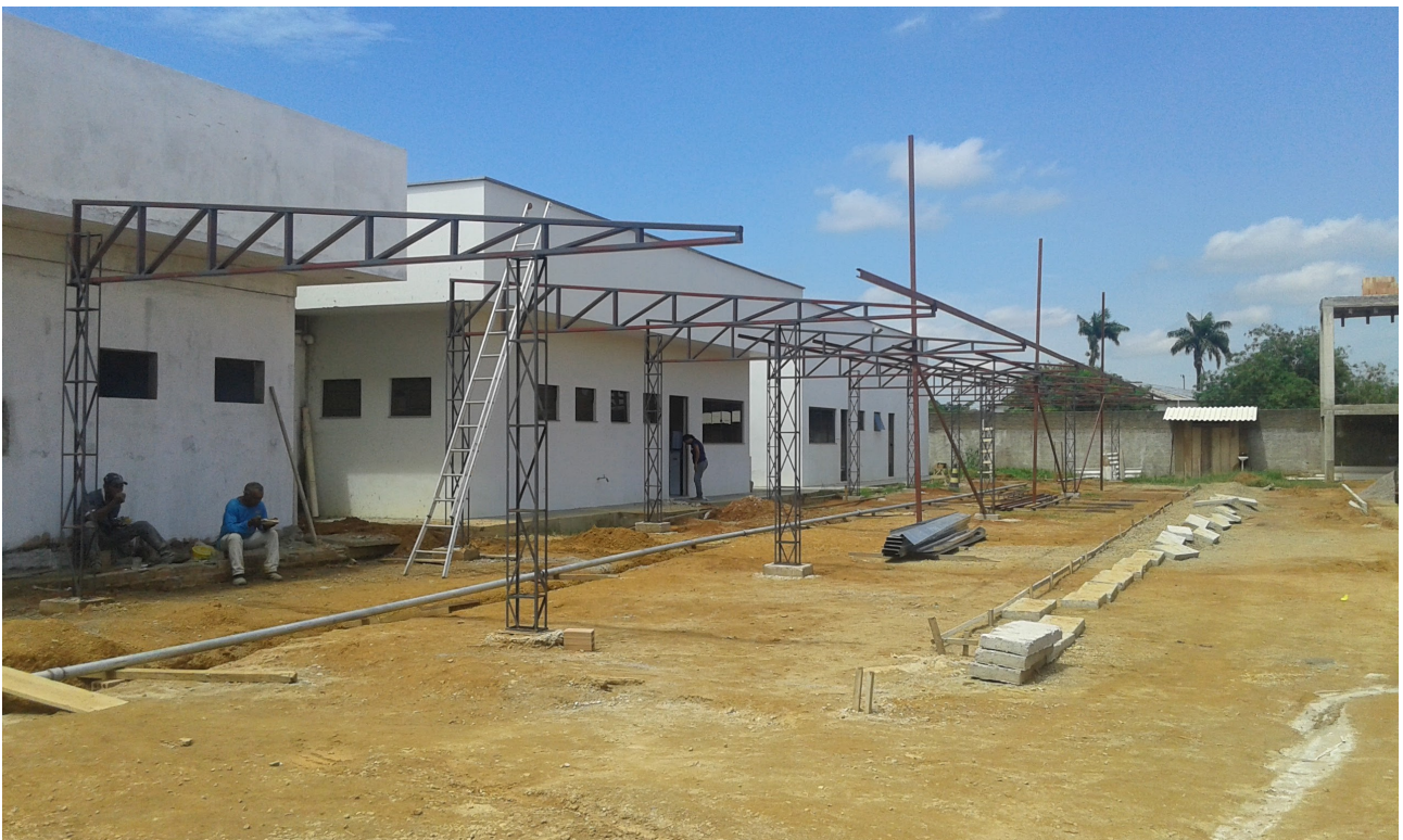
Ilustração 2: Visão externa da obra e execução da estrutura metálica para cobertura do estacionamento.
