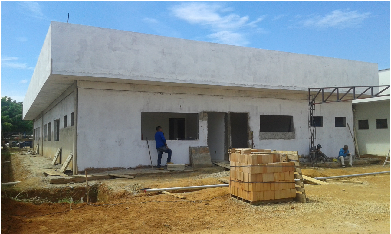
Ilustração 3: Visão posterior externa da obra – Aplicação de selador.
