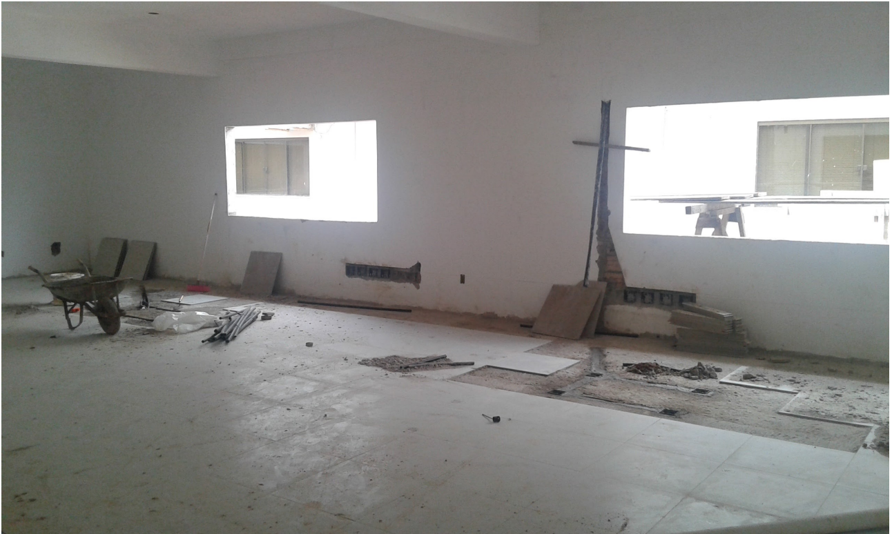
Ilustração 5: Ambiente interno (secretaria) em fase de acabamentos (revestimento de piso, tomadas elétricas e paredes emassadas e lixadas).
