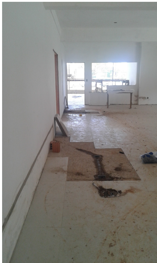
Ilustração 4: Execução de porcelanato e tomadas elétricas no piso da secretaria.
