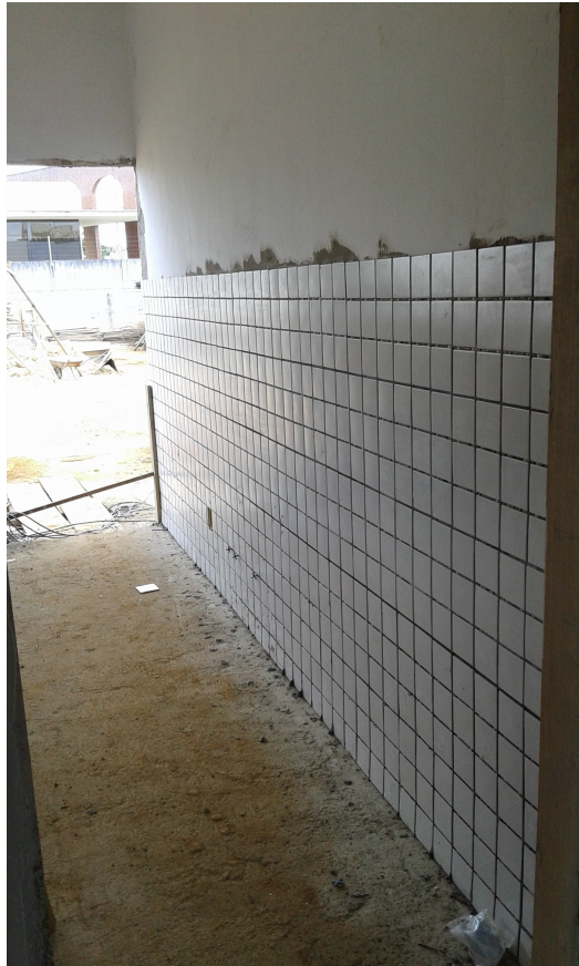
Ilustração 7: Execução de revestimento cerâmico em paredes da copa.
