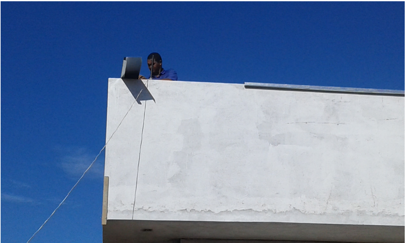
Ilustração 8: Execução de calhas e rufos.
