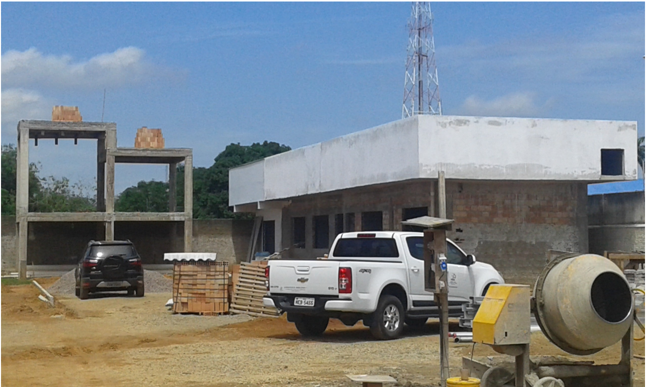
Ilustração 1: Visão externa da obra – Arquivos e Reservatório Elevado.
