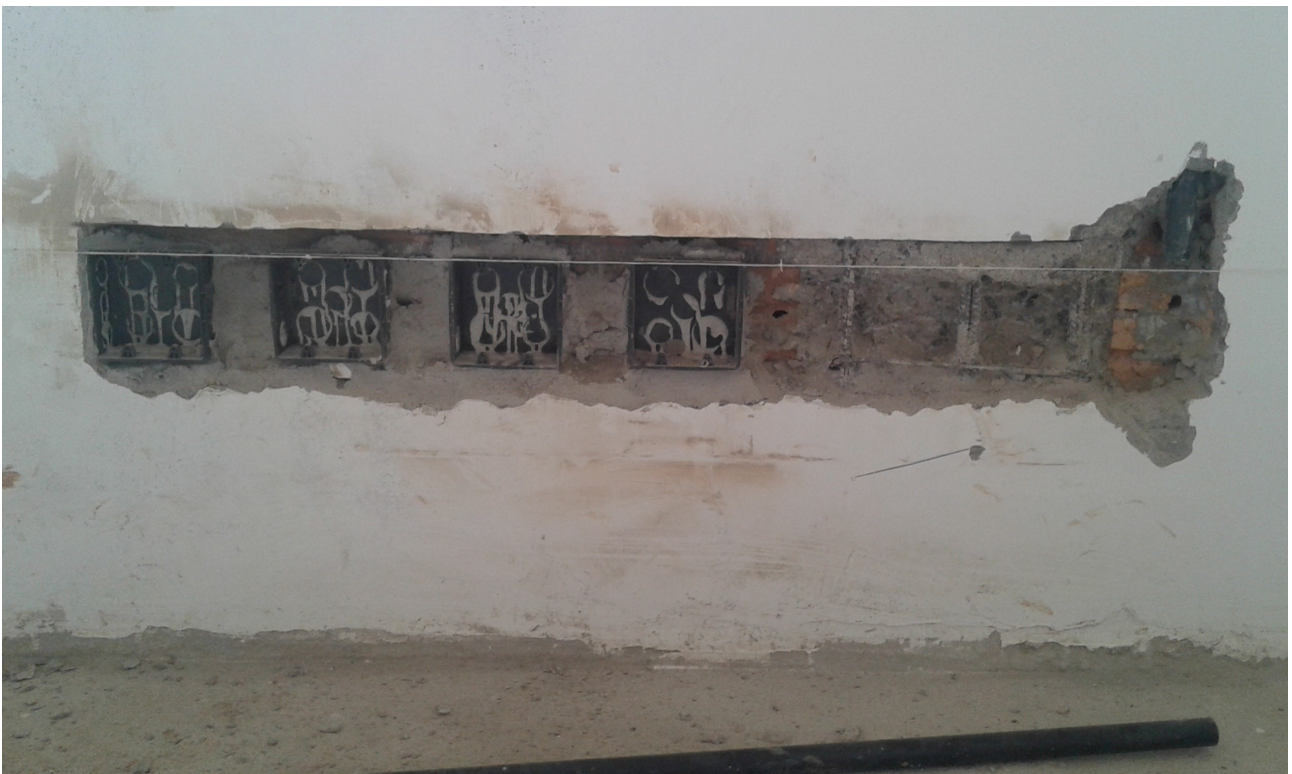
Ilustração 6: Assentamento de caixas de passagem da rede lógica.
