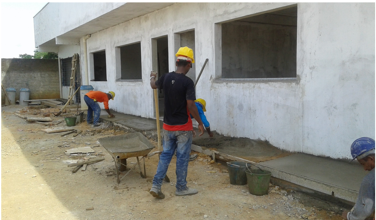
Ilustração 12: Execução de calçada de proteção contra umidade.
