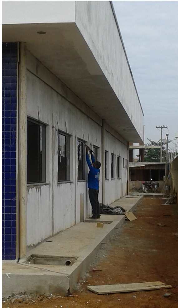
Ilustração 7: Instalação de janelas em vidro temperado.
