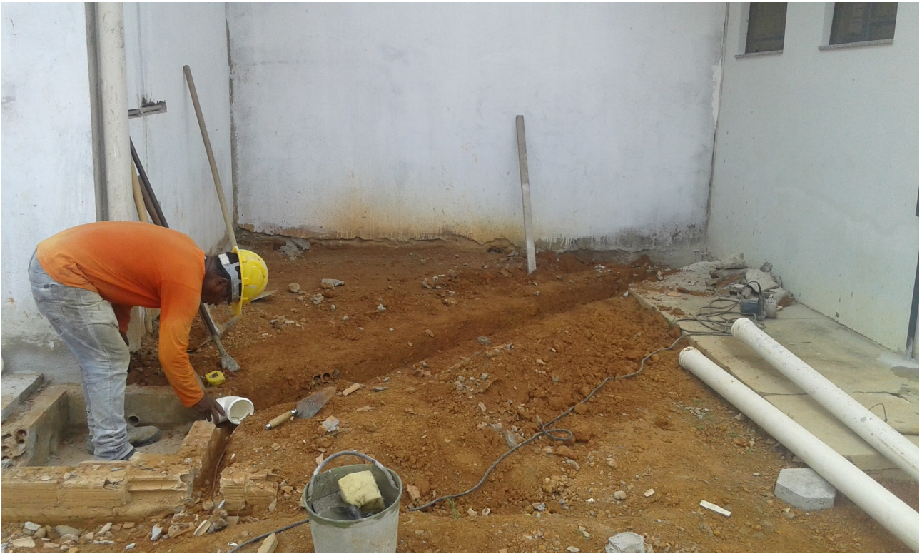
Ilustração 5: Execução de instalações para drenagem pluvial.
