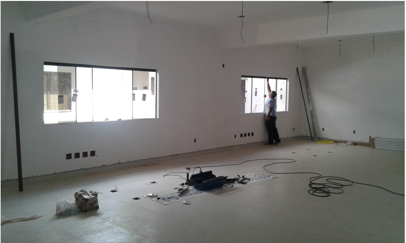
Ilustração 1: Instalação de esquadrias em vidro temperado.
