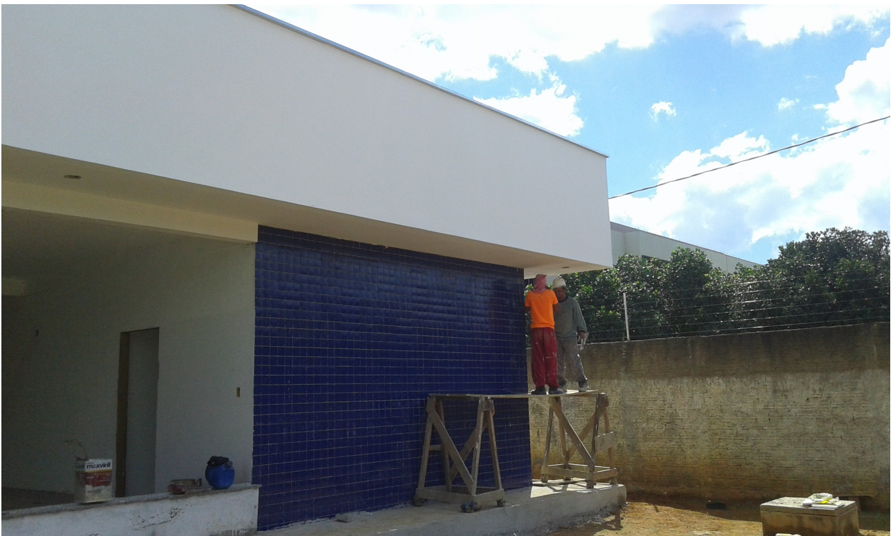
Ilustração 2: Assentamento de revestimento cerâmico em fachada.
