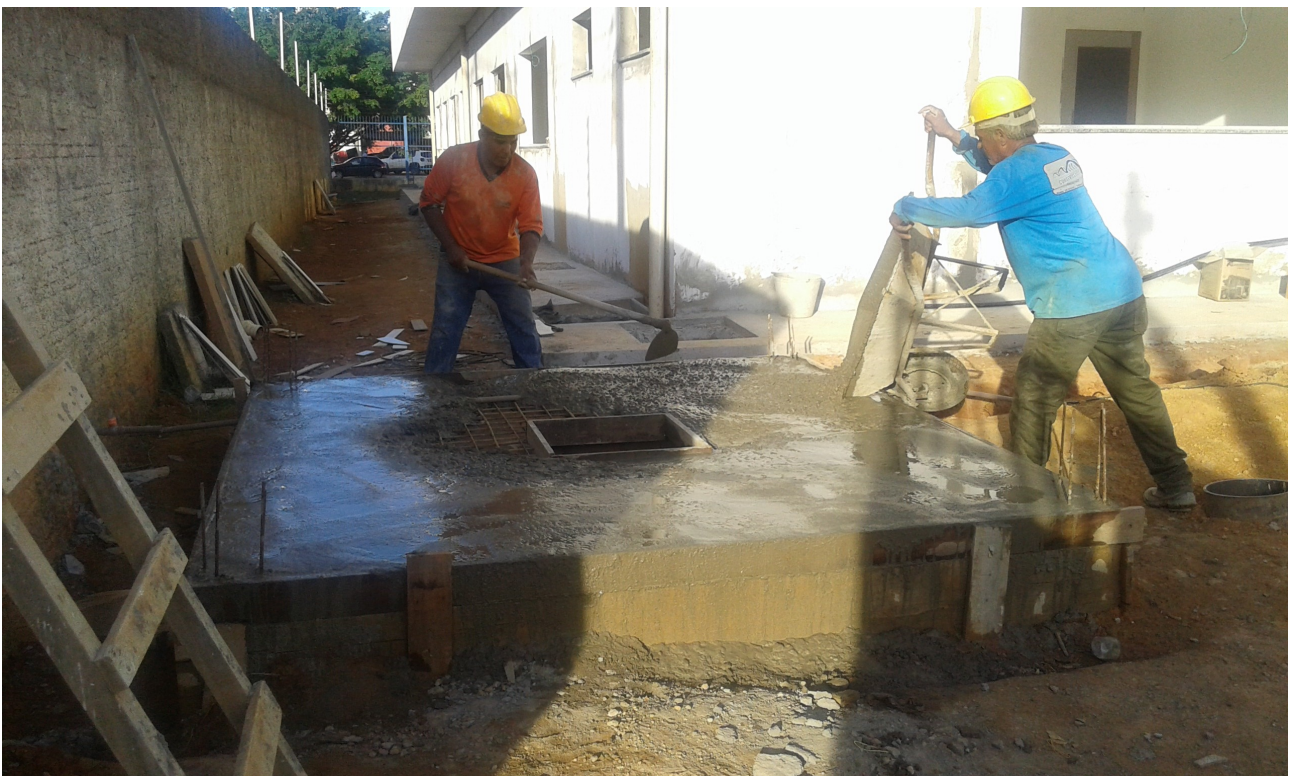
Ilustração 4: Execução de reservatório semienterrado para reaproveitamento de águas pluviais.
