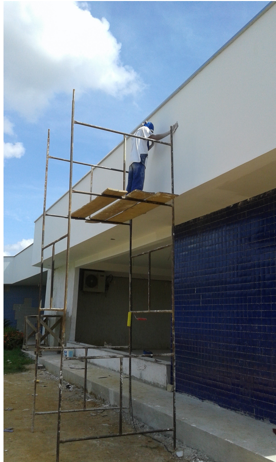
Ilustração 9: Acabamento de fachada com lixamento.
