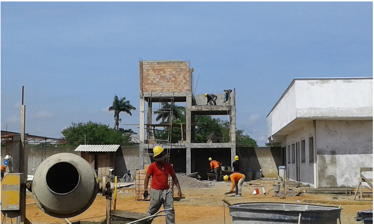
Ilustração 8: Execução dos reservatórios elevados de água.
