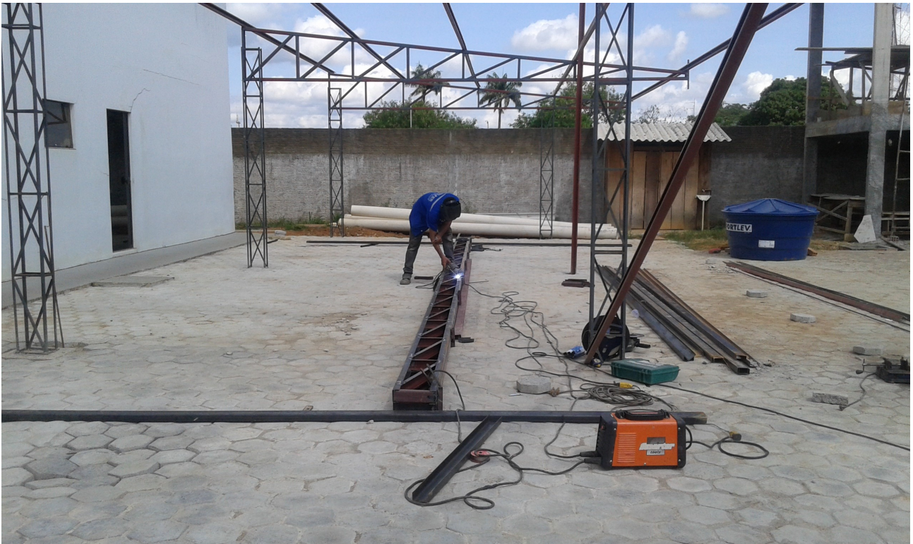
Ilustração 10: Execução de solda e montagem de estrutura metálica para telhado do estacionamento.
