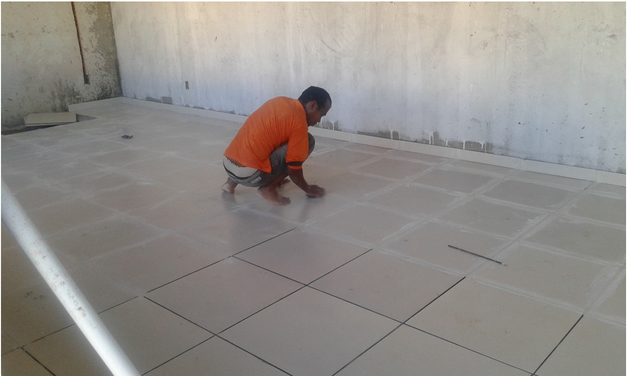
Ilustração 3: Execução de rejuntamento em piso cerâmico dos arquivos.
