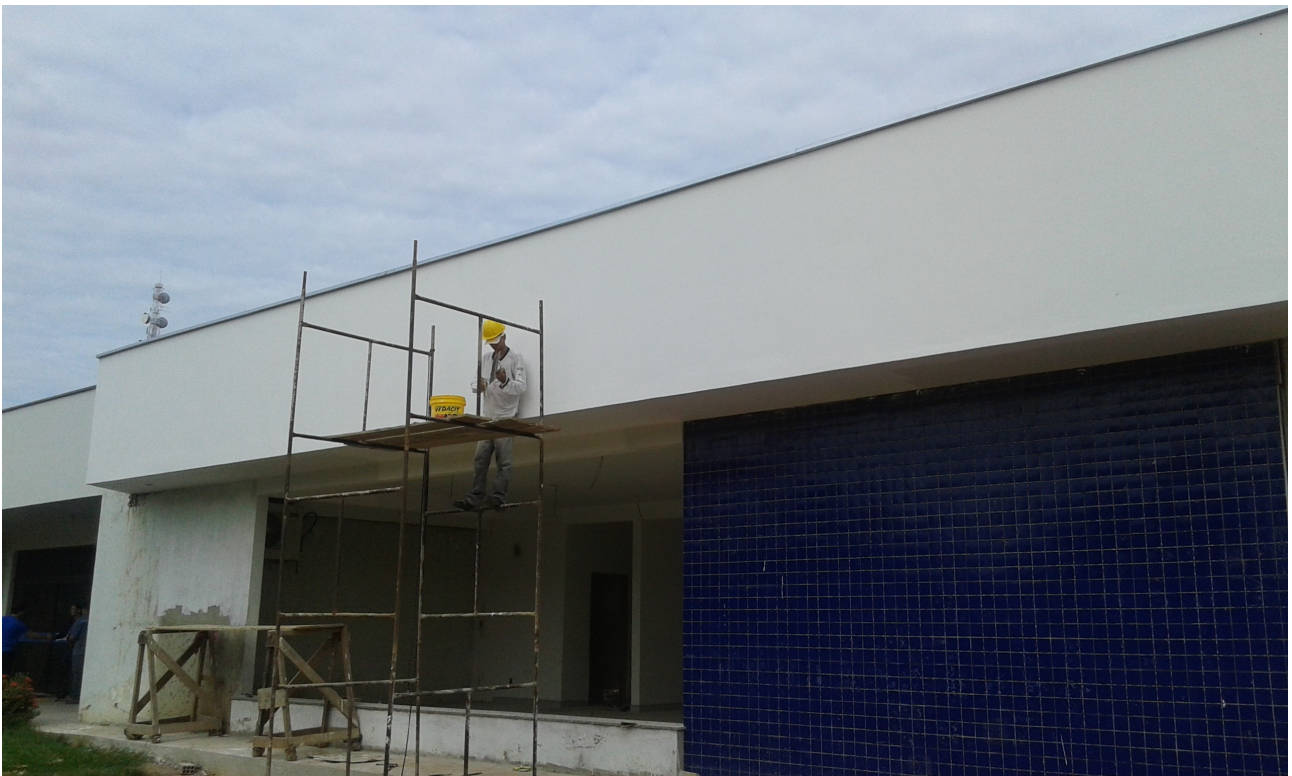
Ilustração 6: Execução de emassamento e lixamento em fachada.
