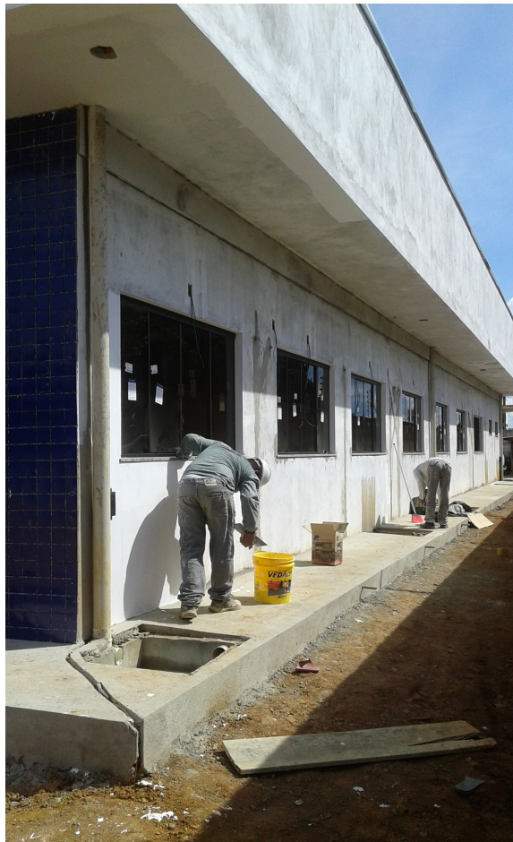
Ilustração 11: Aplicação de massa acrílica para acabamento de parede externa.
