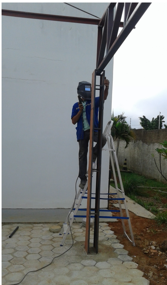
Ilustração 11: Execução de solda em estrutura metálica para estacionamento.
