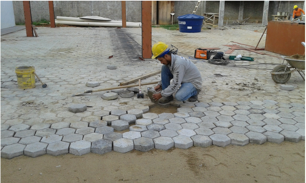
Ilustração 7: Execução de calçada com piso intertravado hexagonal - Estacionamento.
