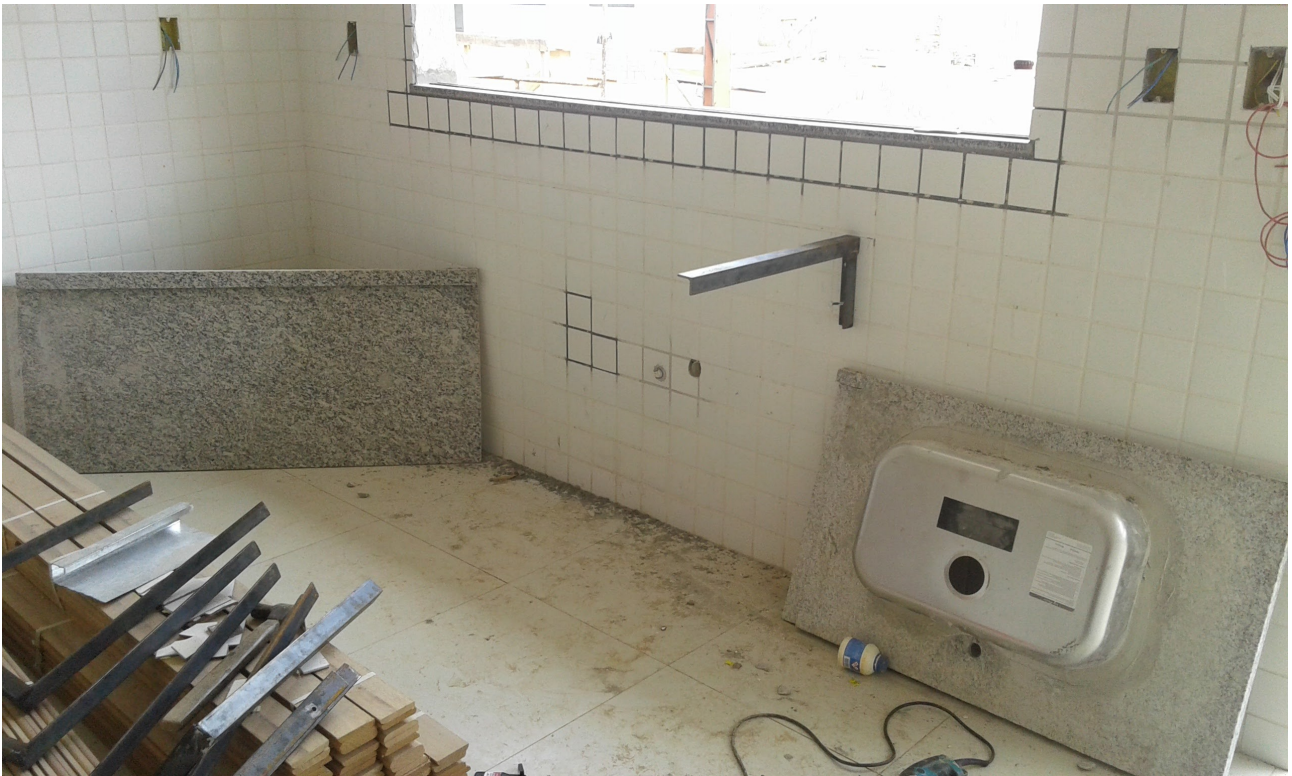
Ilustração 13: Assentamento de bancada de granito de pia de cozinha.
