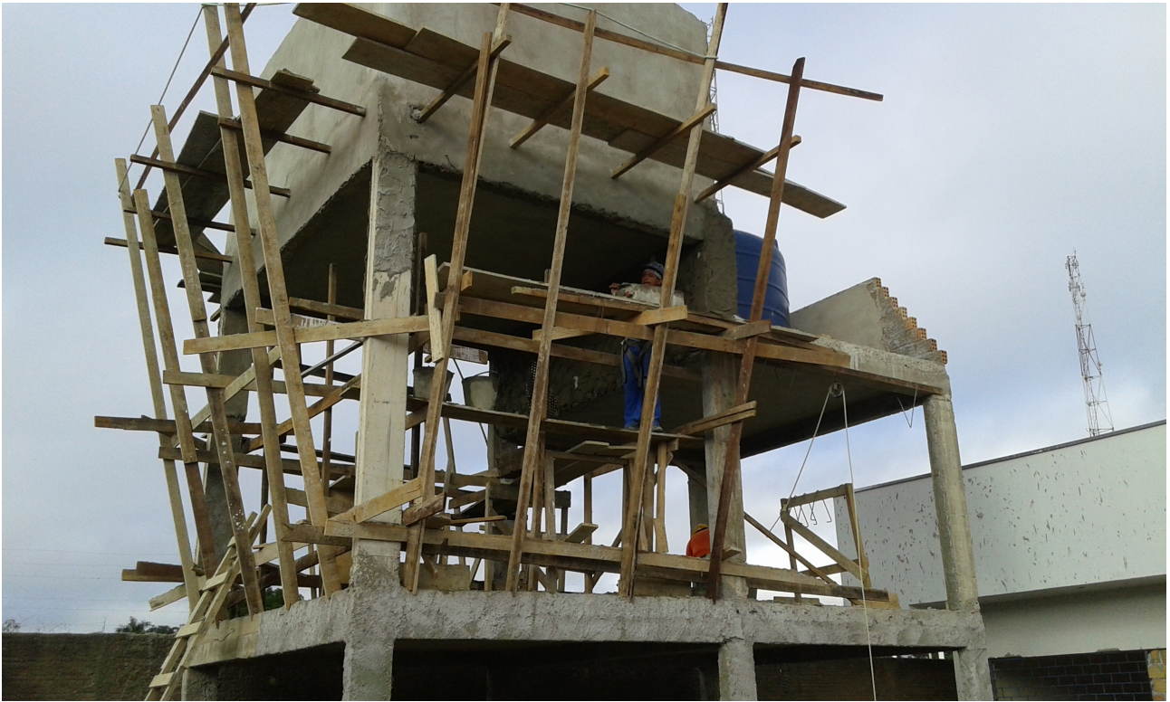
Ilustração 9: Cimbramento e reboco de reservatório elevado de água.
