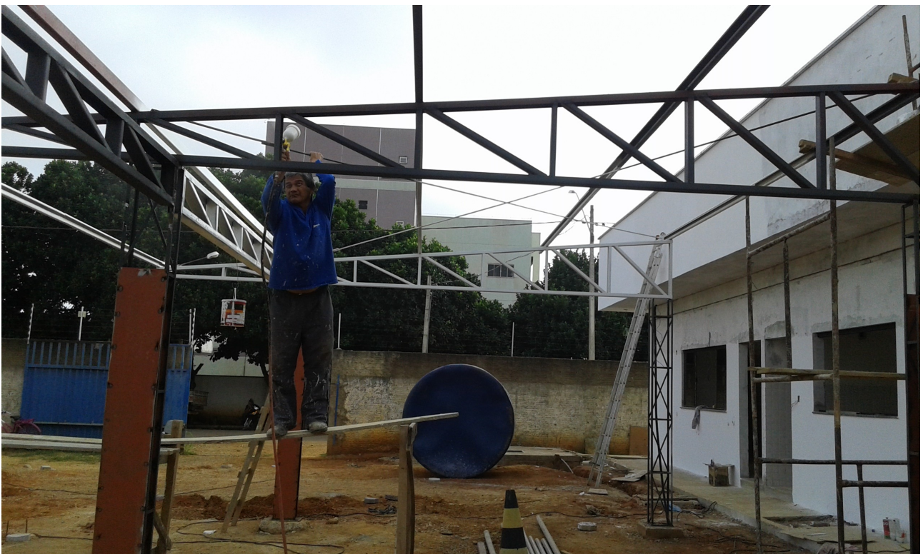
Ilustração 6: Pintura de estrutura metálica para estacionamento.
