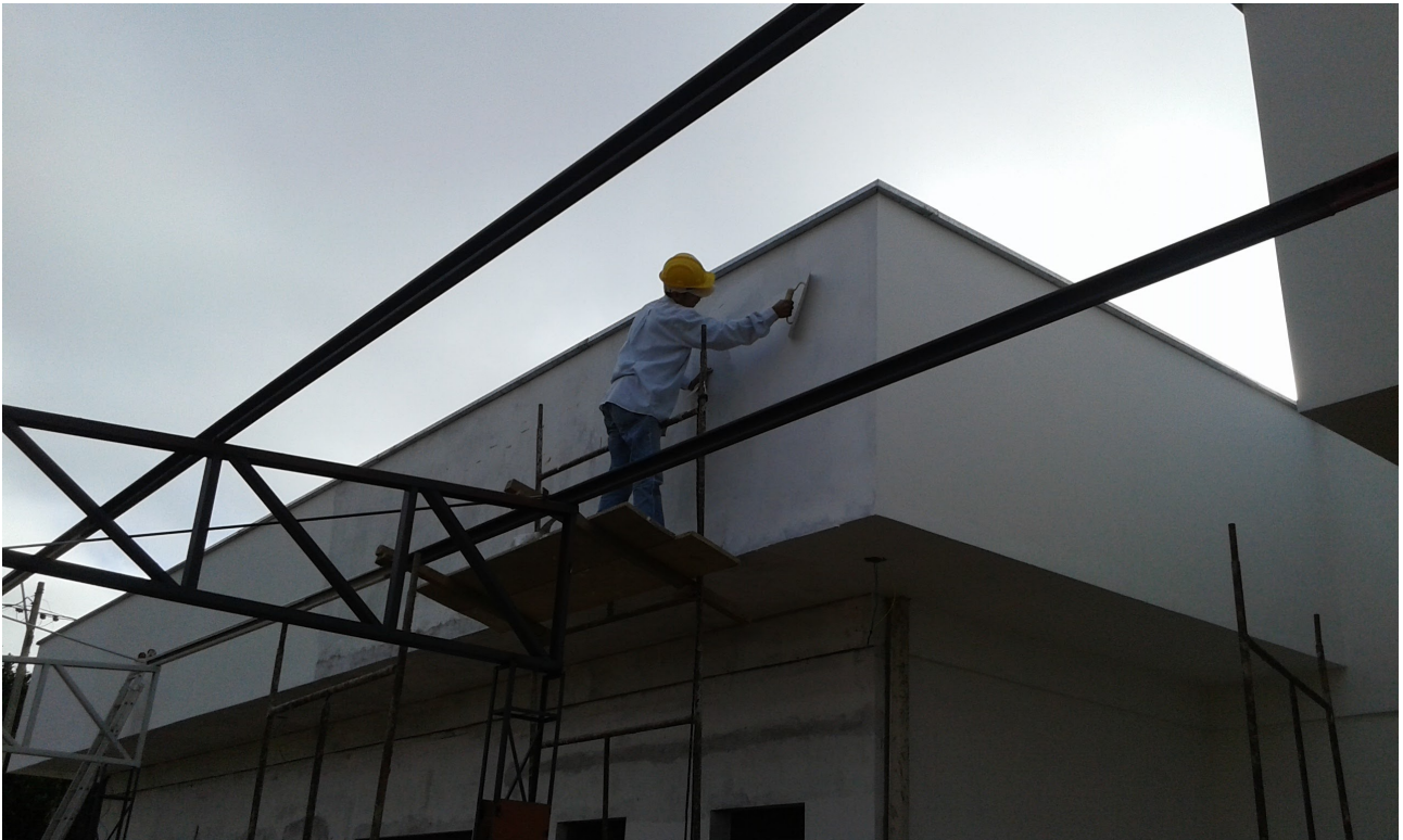
Ilustração 5: Aplicação de massa para acabamento de fachada (platibandas).
