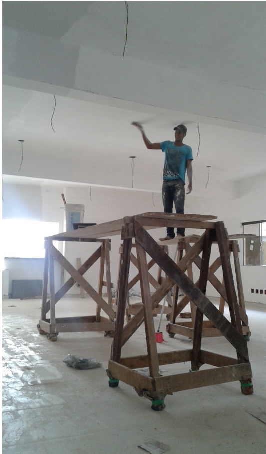
Ilustração 3: Aplicação de massa corrida e lixamento para acabamento de paredes internas - secretaria.
