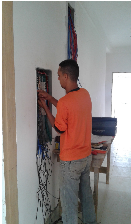
Ilustração 10: Finalização do quadro de distribuição de circuitos elétricos.
