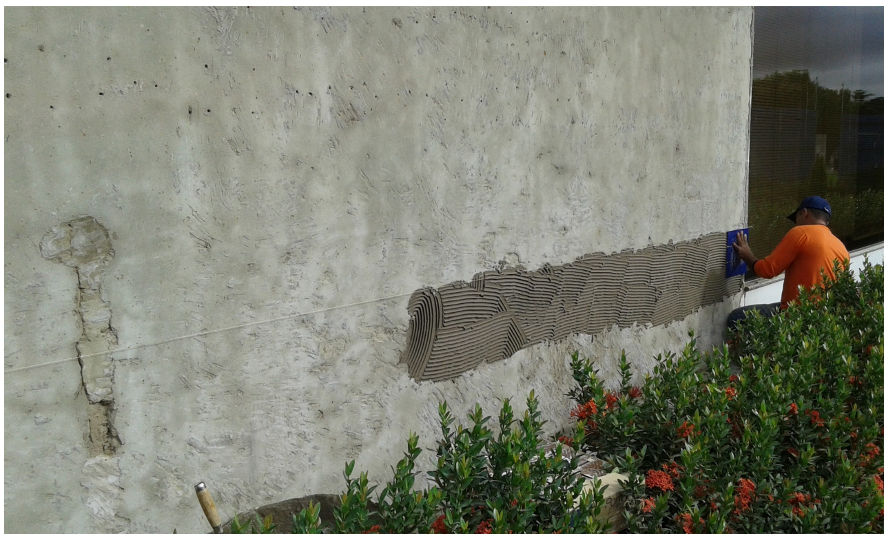
Ilustração 12: Aplicação de argamassa para assentamento de peças cerâmicas em parede externa.
