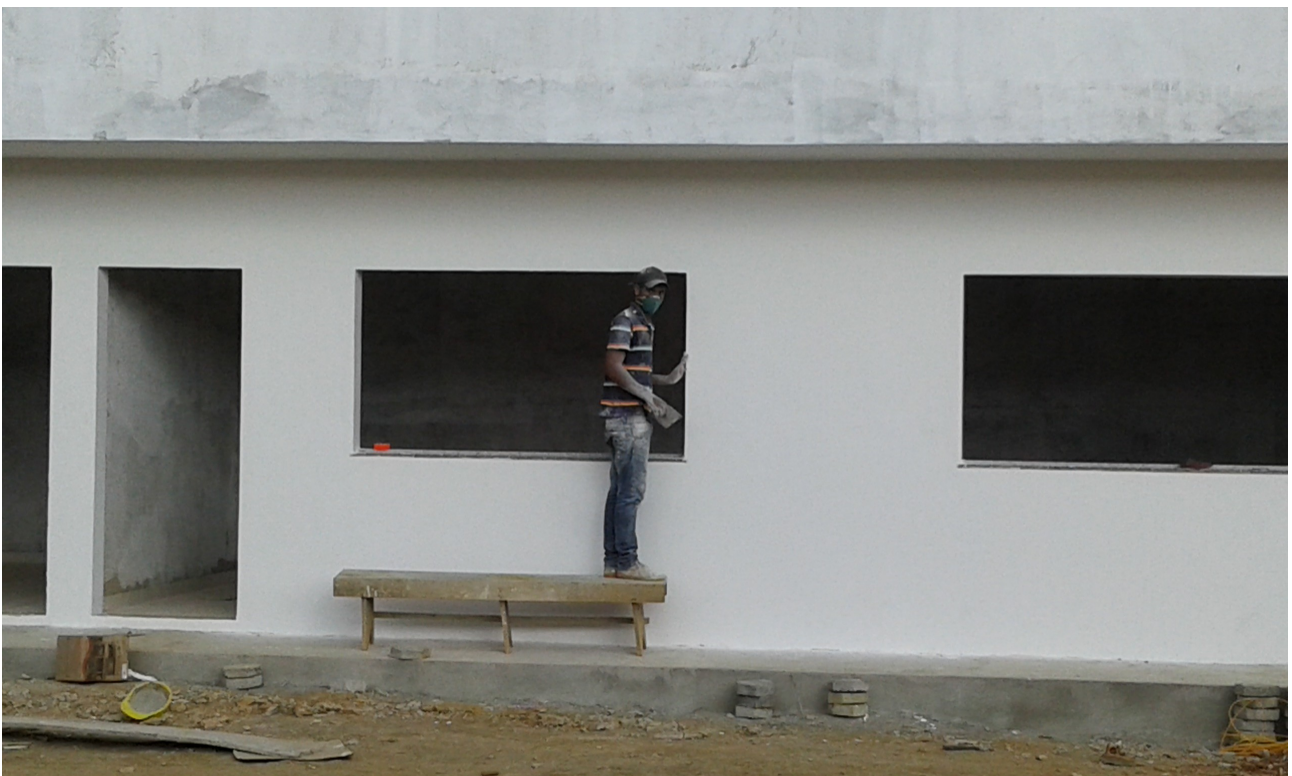
Ilustração 8: Lixamento para acabamentos externos - Arquivos.
