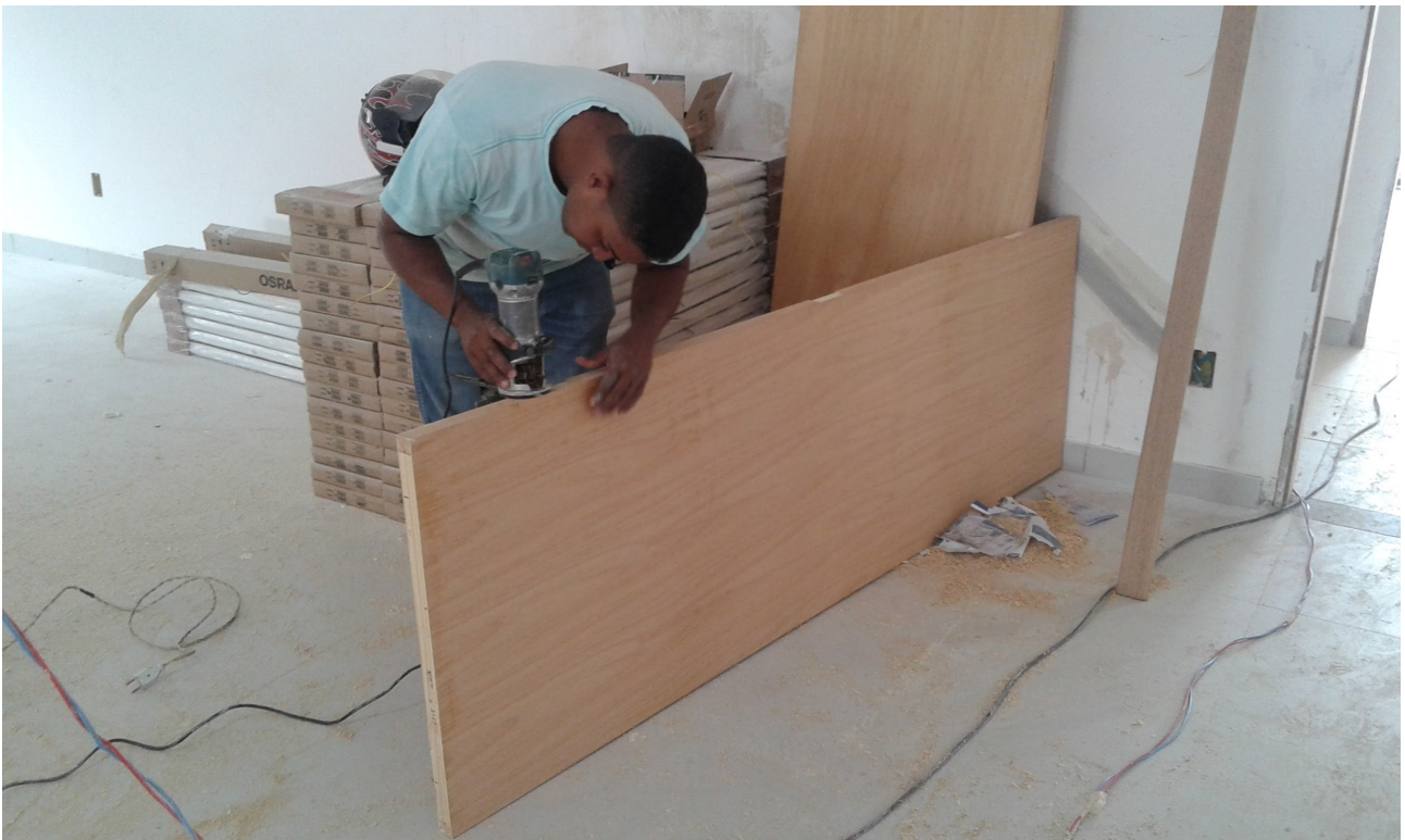
Ilustração 14: Preparo de folha de porta para instalação.
