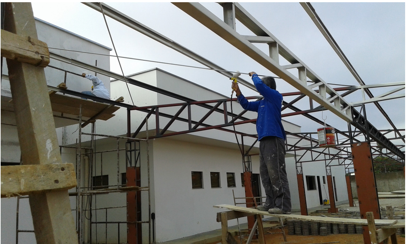
Ilustração 4: Pintura de estrutura metálica para telhado do estacionamento.
