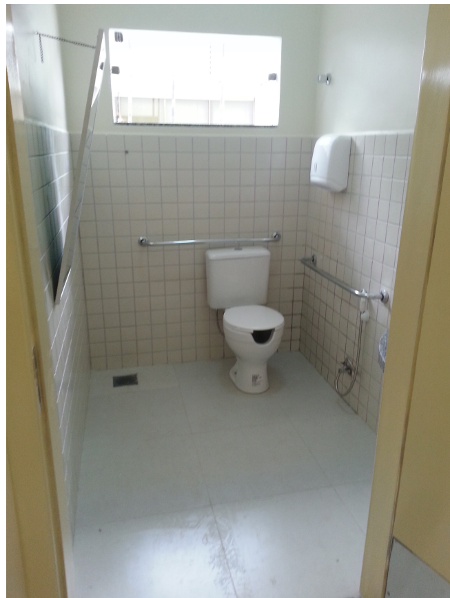
Ilustração 6: Banheiro para pessoas com deficiência executado.
