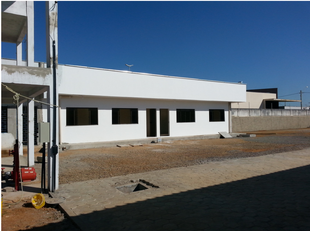
Ilustração 1: Fachada dos arquivos em fase de finalização.
