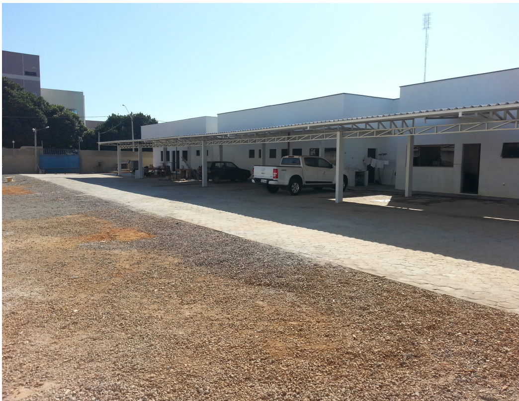
Ilustração 2: Visão posterior da obra em fase de finalização.
