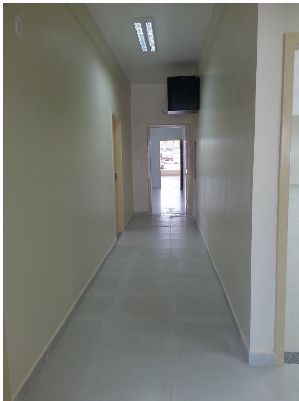
Ilustração 10: Corredor de acesso entre salas executado.
