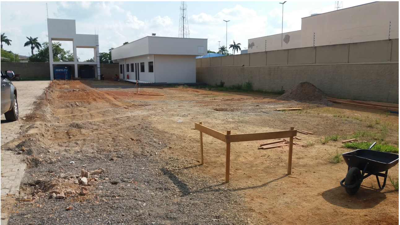
Ilustração 1: Visão externa da obra – Limpeza Final.
