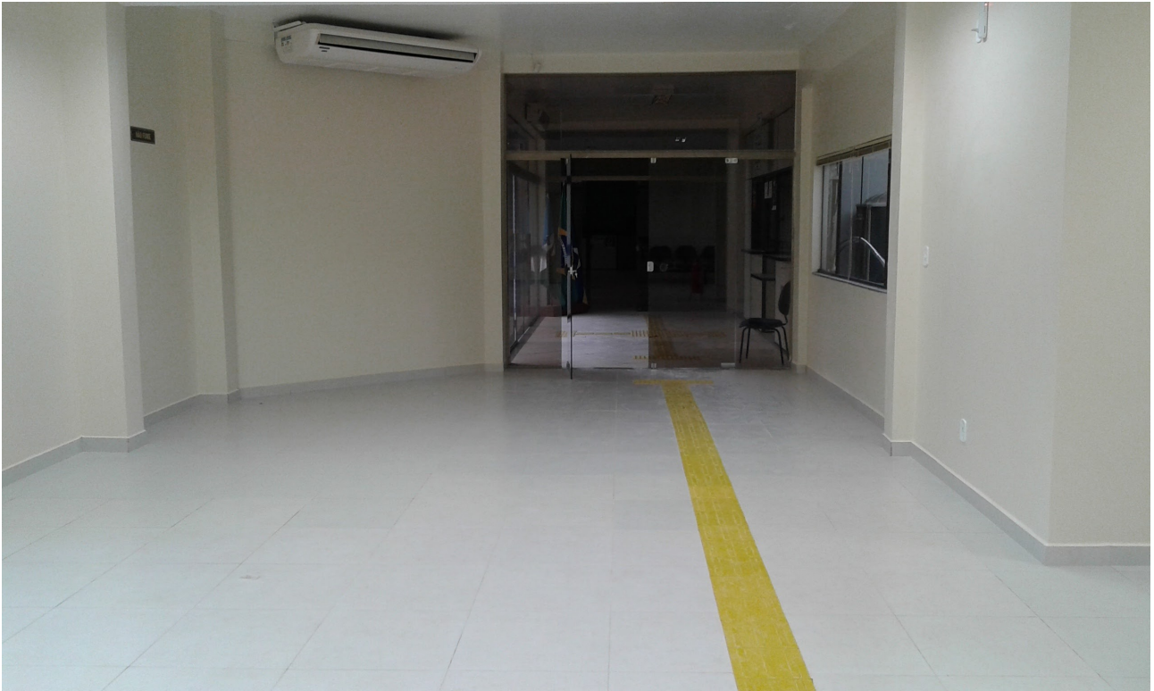
Ilustração 3: Ambiente interno executado, inclusive piso tátil.
