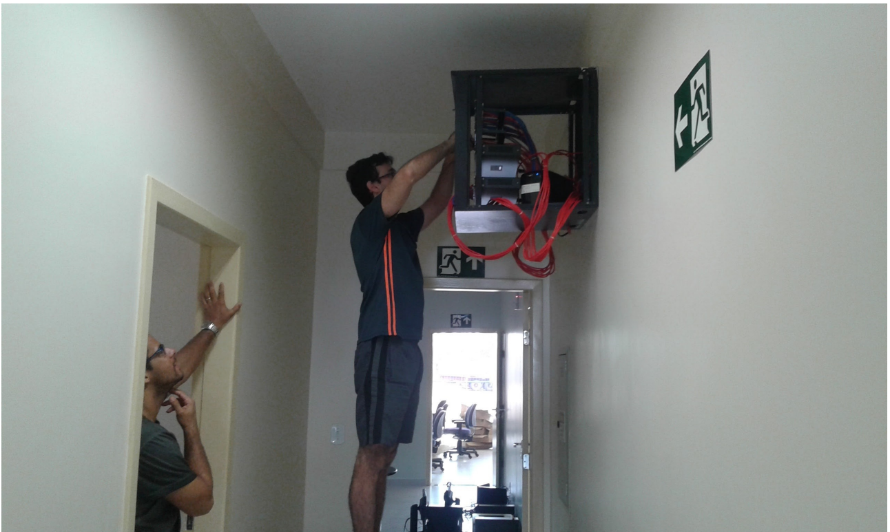
Ilustração 4: Instalação de switches e finalização da rede lógica.
