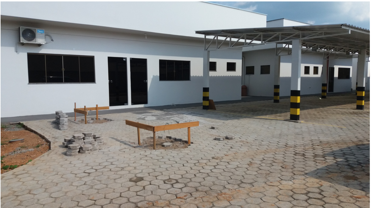
Ilustração 2: Obra em fase final.
