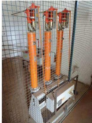
*imagem 16 - Detalhe do disjuntor e relé á serem substituídos.*
