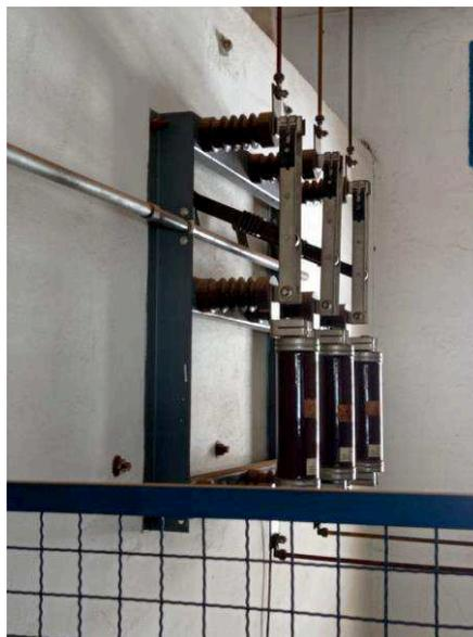
Imagem 10 - Chave Seccionado com fusível HH.
