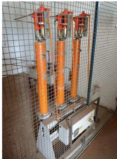
Imagem 8 - Detalhe do disjuntor e relé à serem substituídos.
